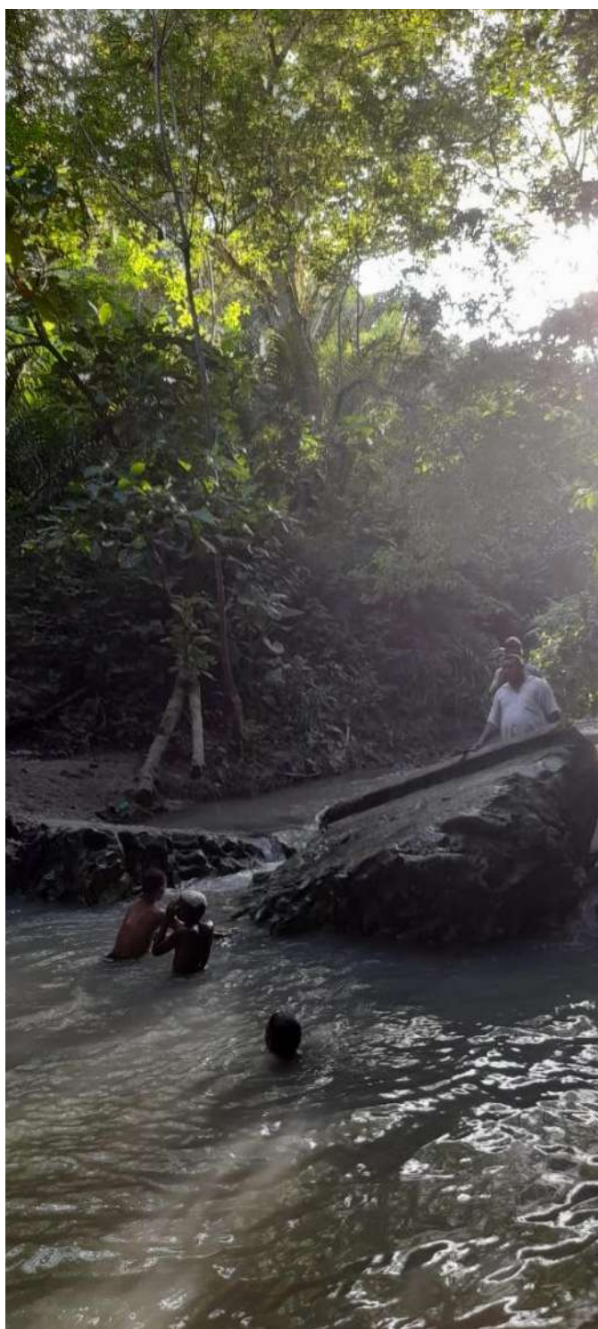
Figura 16 Foto da barragem desativada.
