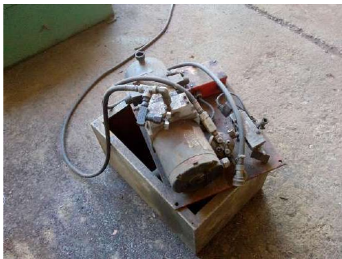
Figura 5 – Registro de máquina mal condicionada durante visita técnica.
