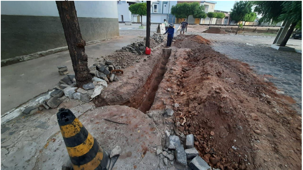
Figura 5 – Manutenção de rede na rua Joana Ferreira de Souza.
