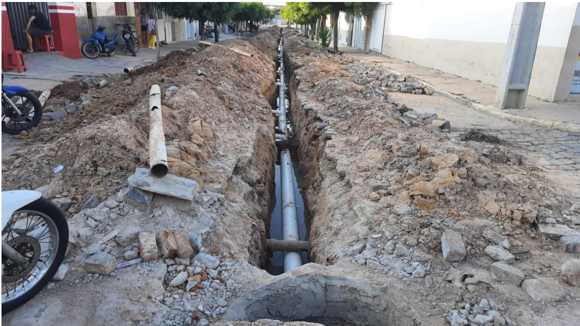
Figura 4 –Manutenção de rede na rua Antônio Soares.
