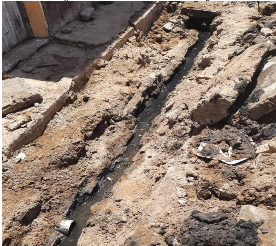
Figura 8 – Sistema arcaico de coleta de esgoto.
