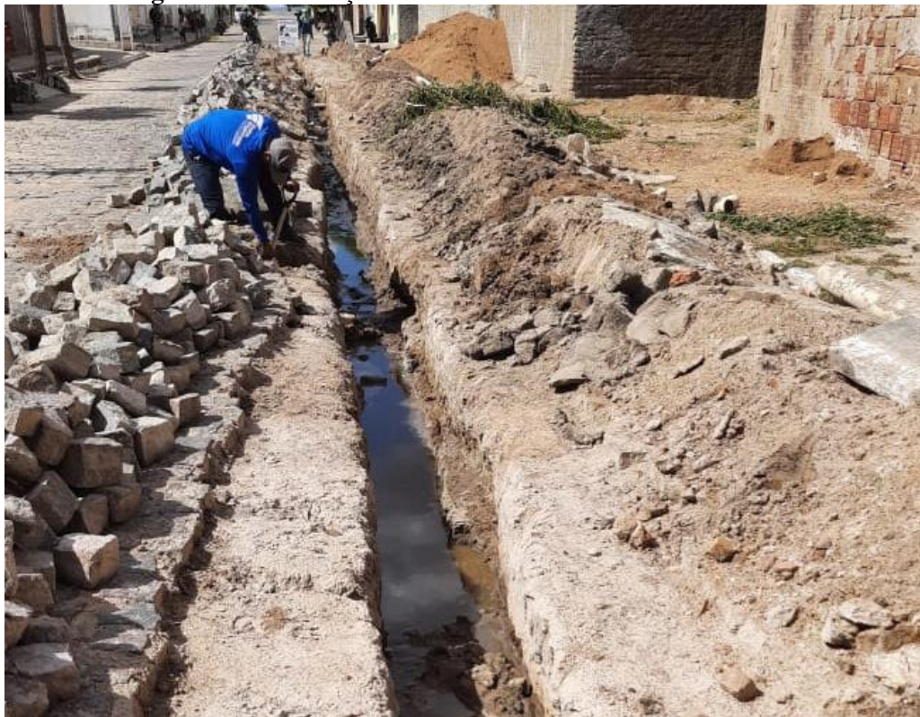
Figura 6 – Manutenção de rede na rua Joana Ferreira de Souza.
