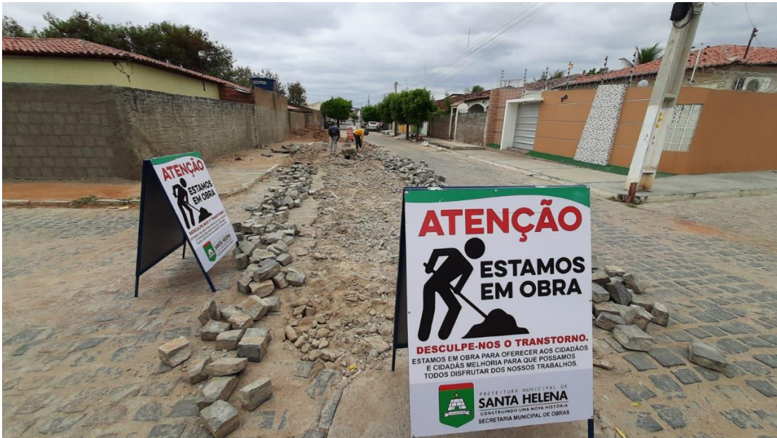
Figura 7 – Manutenção de rede na rua Joana Ferreira de Souza.
