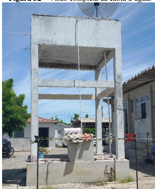
Figura 32 – Visão completa da caixa d'água.
