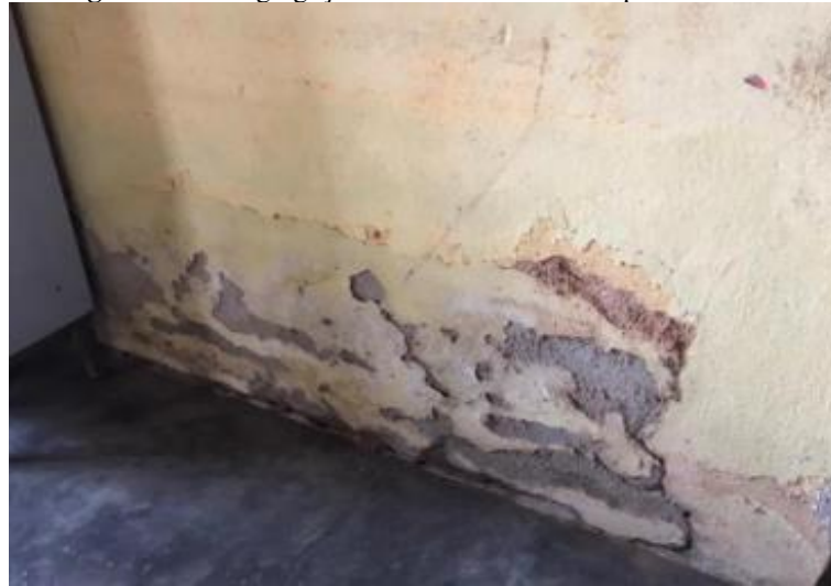
Figura 8 – Desagregação do revestimento com pulverulência.
