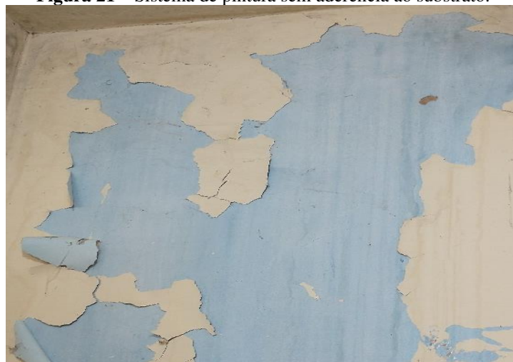
Figura 21 – Sistema de pintura sem aderência ao substrato.
