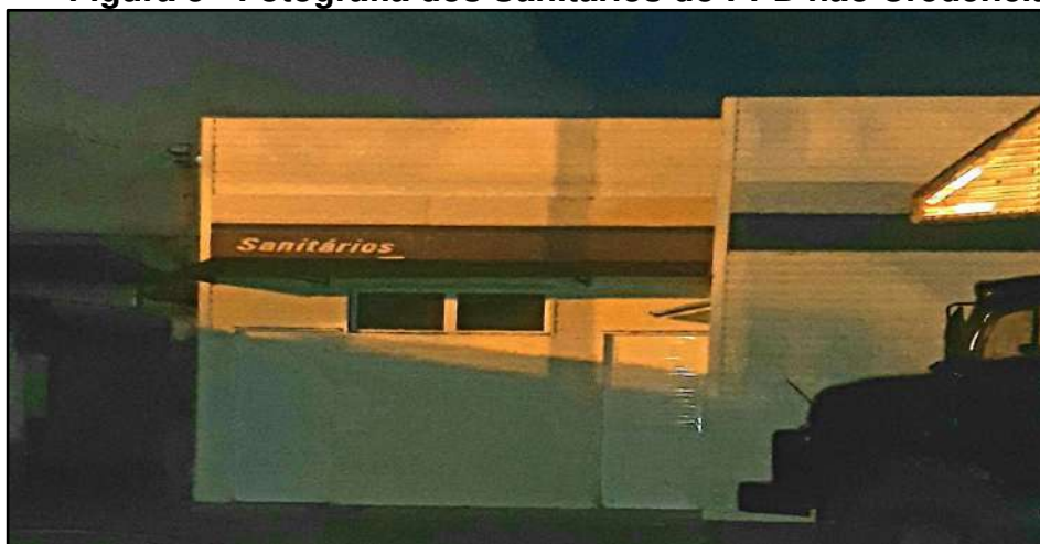
Figura 5 - Fotografia dos Sanitários do PPD não Credenciado
