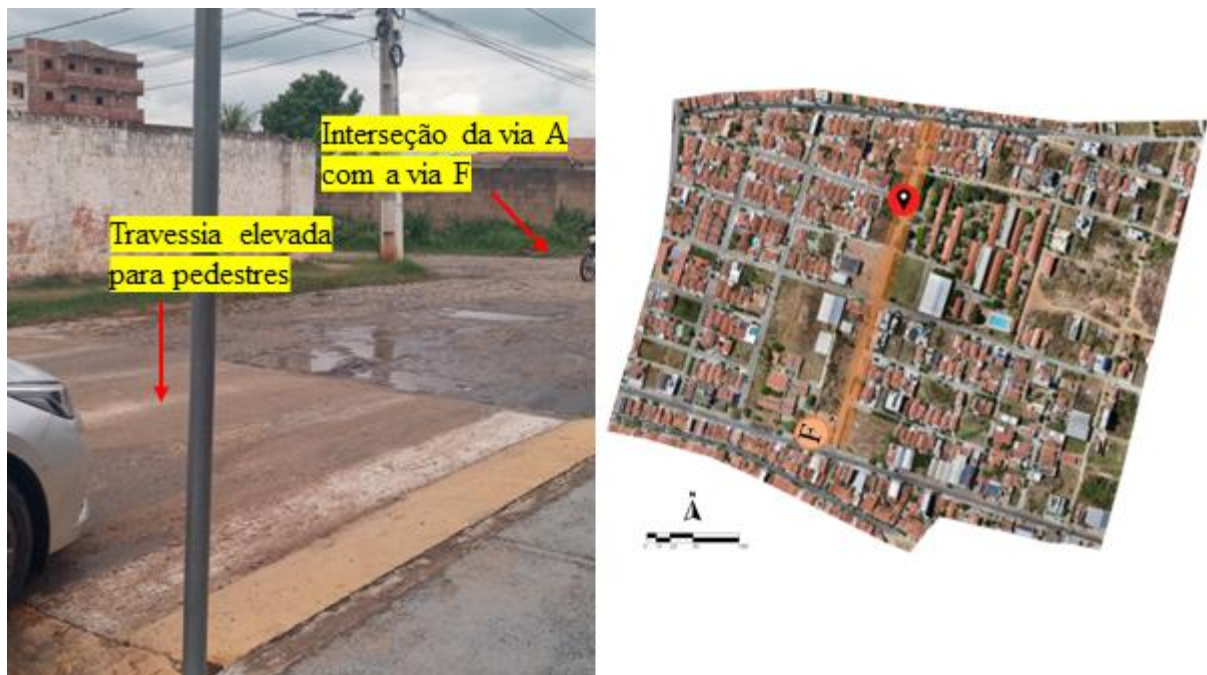
Figura 17- Travessia elevada para pedestres próxima à interseção A-F
