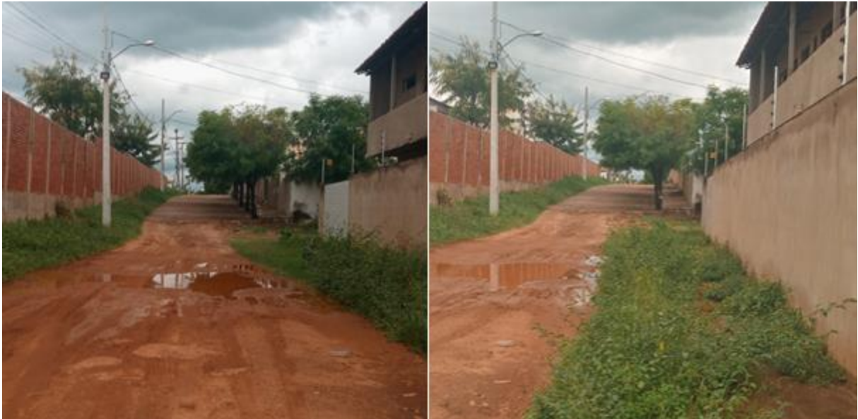
Figura 7 - Trecho irregular e de risco na via G
