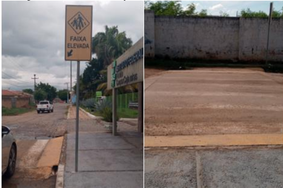
Figura 8 - Travessia elevada de pedestres na via F - Rua José Dantas Nobres
