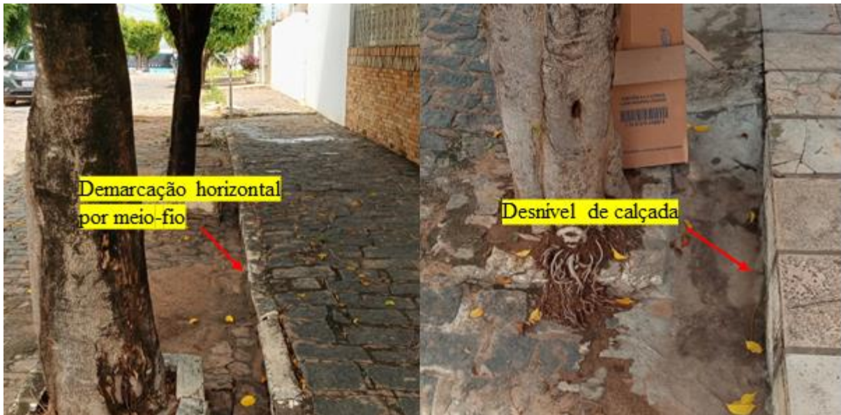
Figura 9 - “Demarcação horizontal” representada por meio-fio e por desnível de calçada
