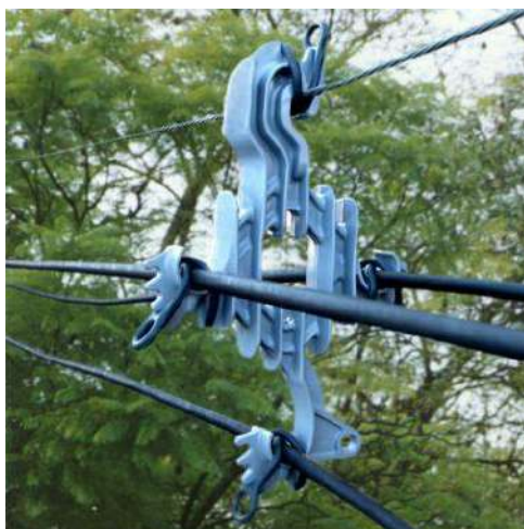
Figura 15 – Rede primária área compacta em cabos protegidos.
