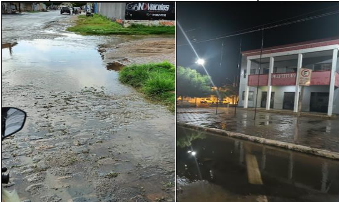
Figura 8 - Rua Antônio Pereira Filho e Rua Cel. Juvêncio Carneiro após chuvas.
