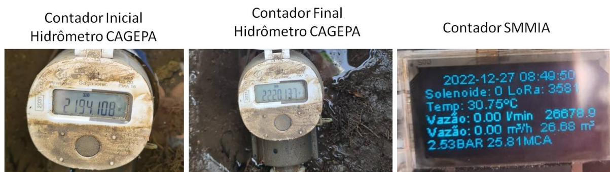
Figura 38 – Comparação do volume total contabilizado entre o SMMIA e o hidrometro SAGA da CAGEPA com o solenoide desenergizado. Fonte: Autoria própria.
