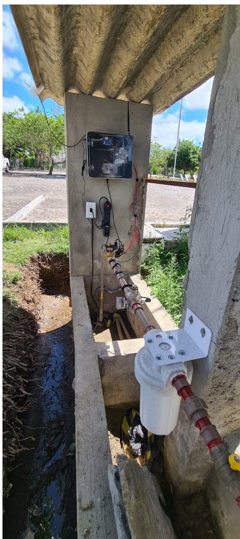
Figura 14 – Instalação do "medidor inteligente de água" no cavalete de entrada de água do campus (perspectiva vertical). Fonte: Autoria própria.
