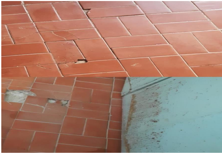
Figura 23 – Piso quebrado.
