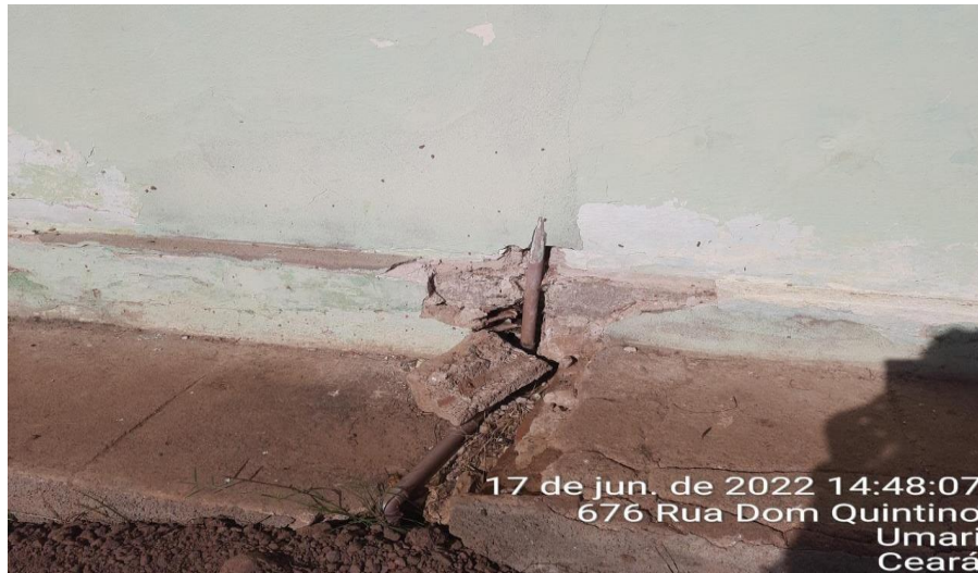
Figura 31 – Tubulação exposta.
