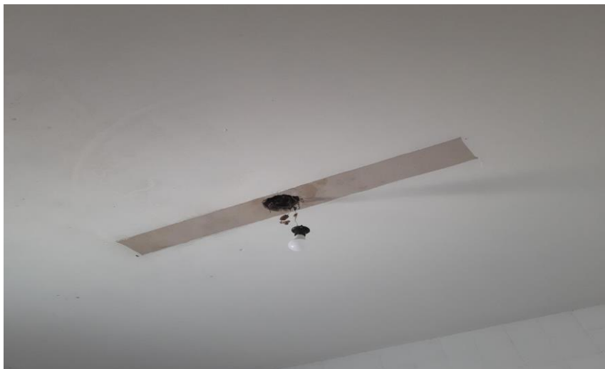
Figura 26 – Instalação da lâmpada exposta.
