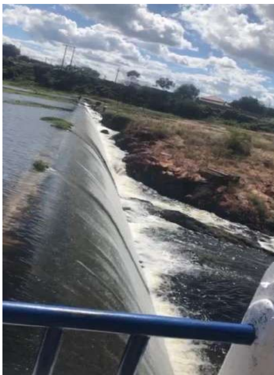
Figura 4: Sangradouro açude São Gonçalo/Sousa-PB
