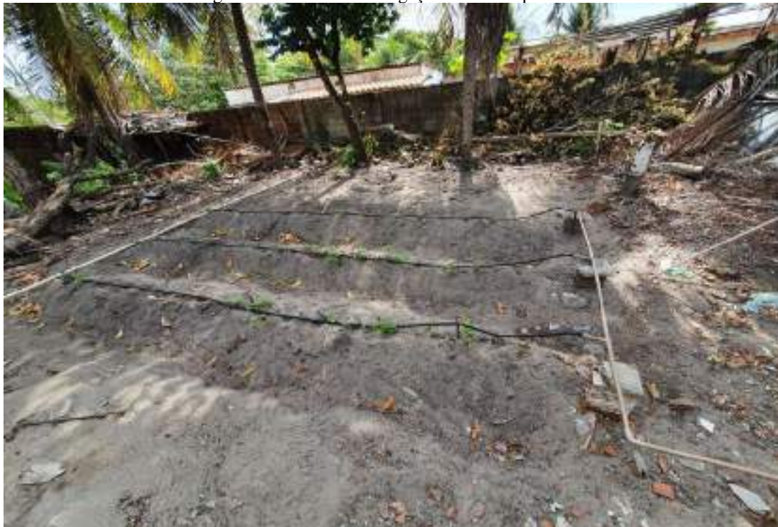
Figura 73 – Sistema de irrigação durante o processo.
