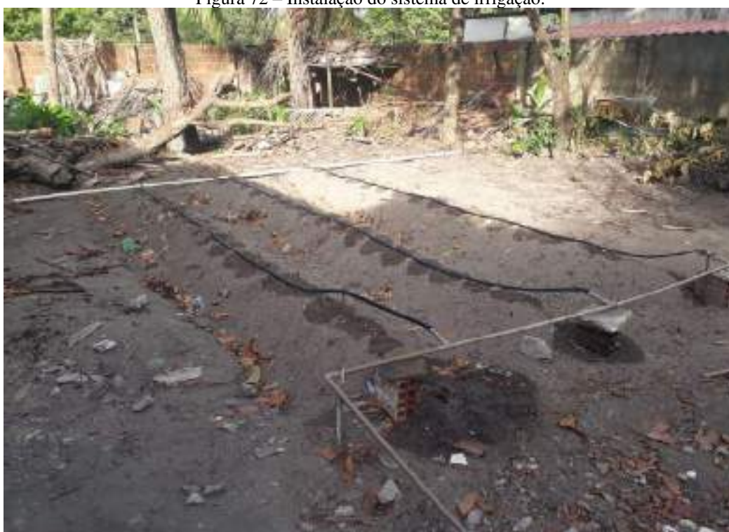
Figura 72 – Instalação do sistema de irrigação.
