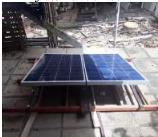
Figura 58 – Estrutura vista lateral.
