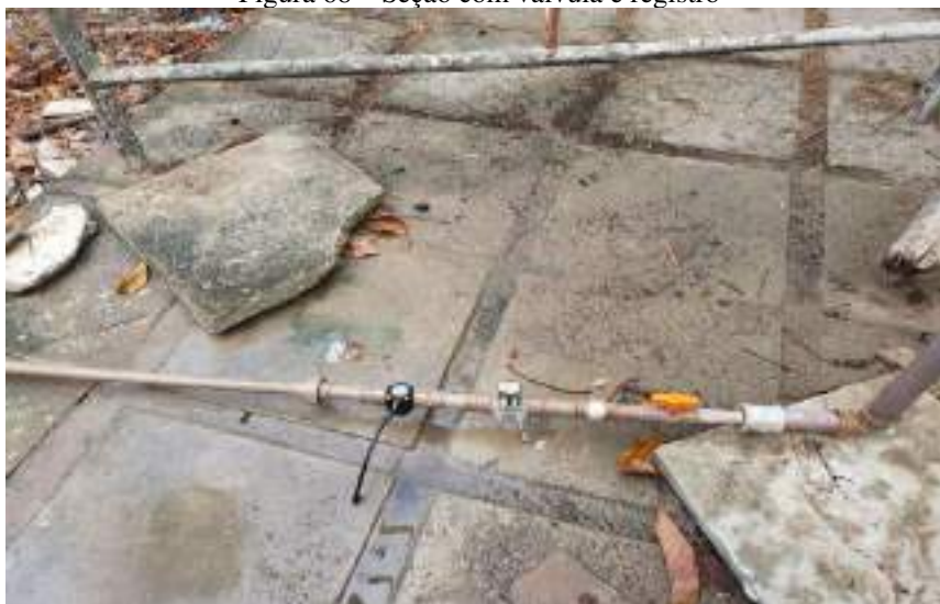
Figura 68 – Seção com válvula e registro
