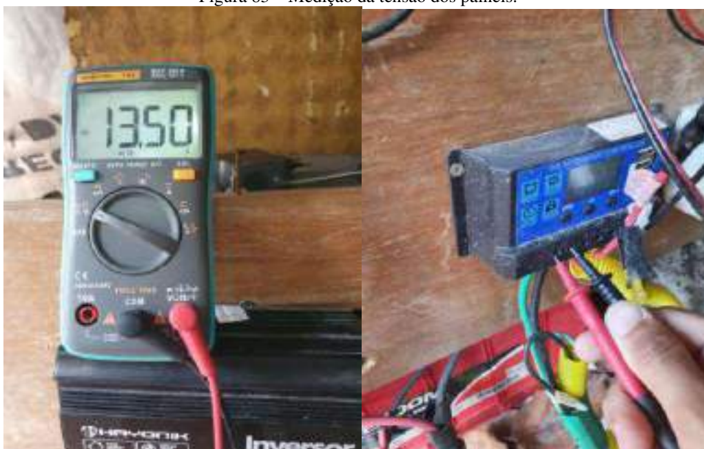
Figura 83 – Medição da tensão dos painéis.
