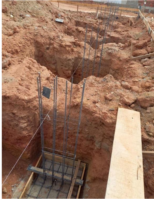
Figura 4 – Execução da sapata isolada
