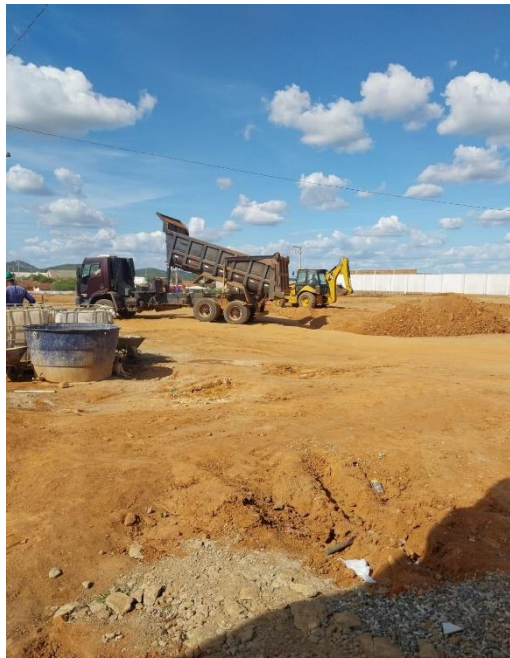
Figura 2 – Despejamento de material para terraplanagem
