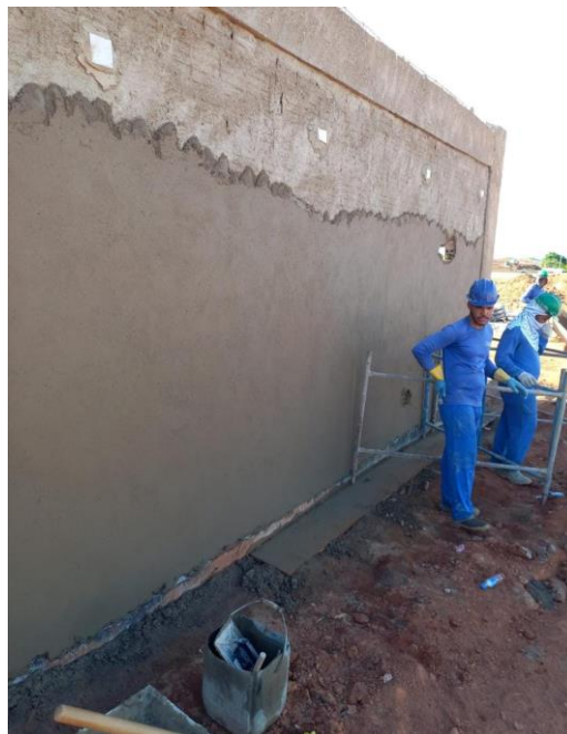
Figura 15 – Revestimento das alvenarias
