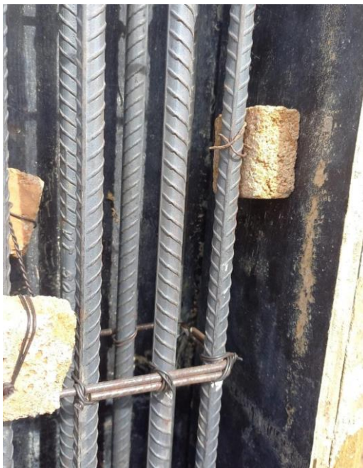
Figura 8 – Espaçadores de argamassa (cocadas)
