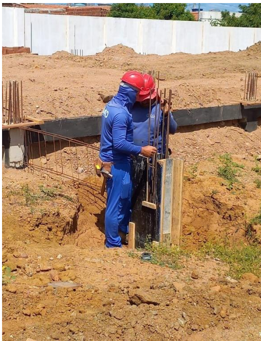
Figura 7 – Posicionamento das ferragens
