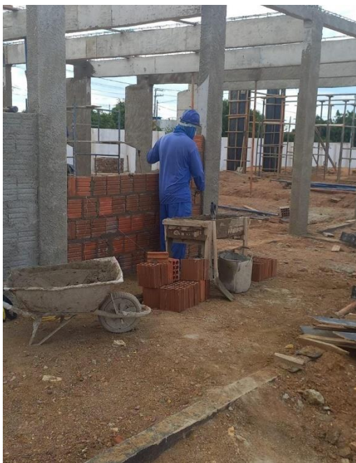
Figura 14 – Levantamento da alvenaria de vedação
