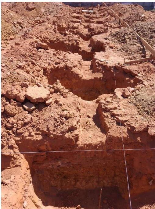
Figura 6 – Valas demarcadas com as linhas de nylon
