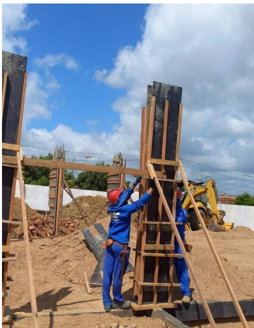
Figura 9- montagem de forma de um pilar
