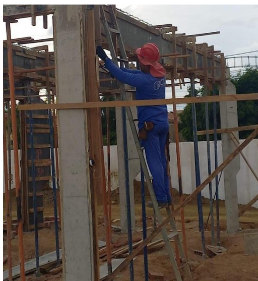
Figura 13 – Escoramento de vigas com estacas metálicas
