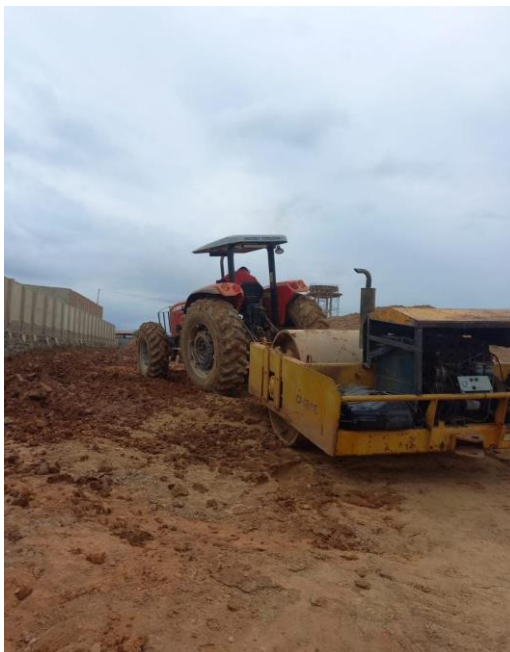
Figura 3 – Rolo compressor utilizado para compactar área da construção
