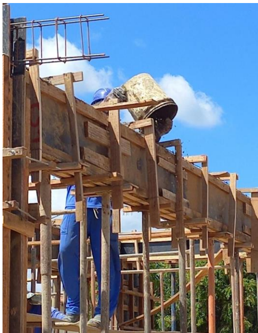
Figura 12 – Concretagem de uma viga superior (lançamento com balde)
