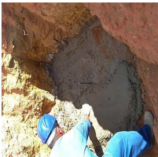
Figura 10 – Concretagem das sapatas
