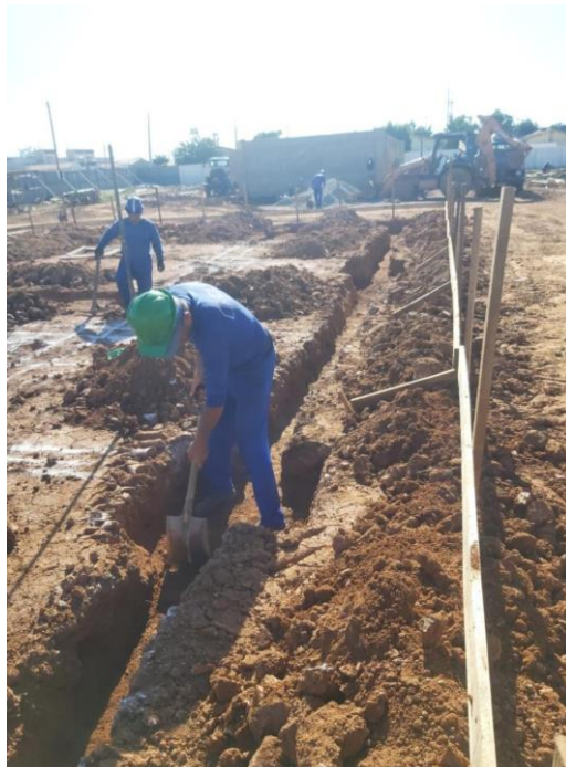
Figura 5 – Escavação da viga baldrame
