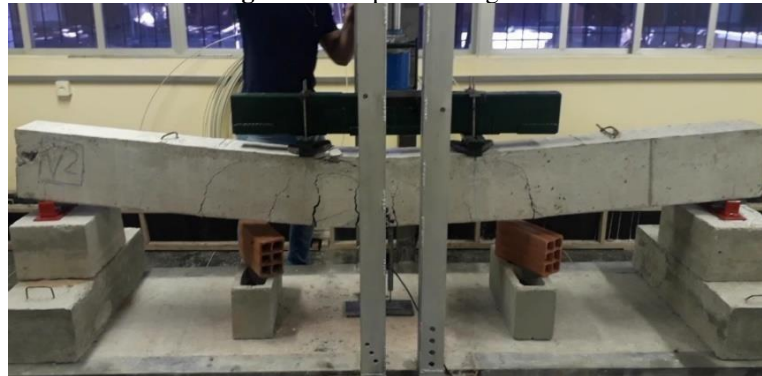
Figura 8 – Ruptura da viga V2.
