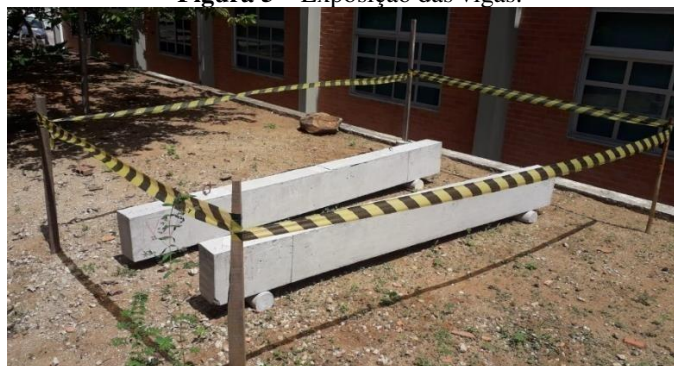
Figura 5 – Exposição das vigas.
