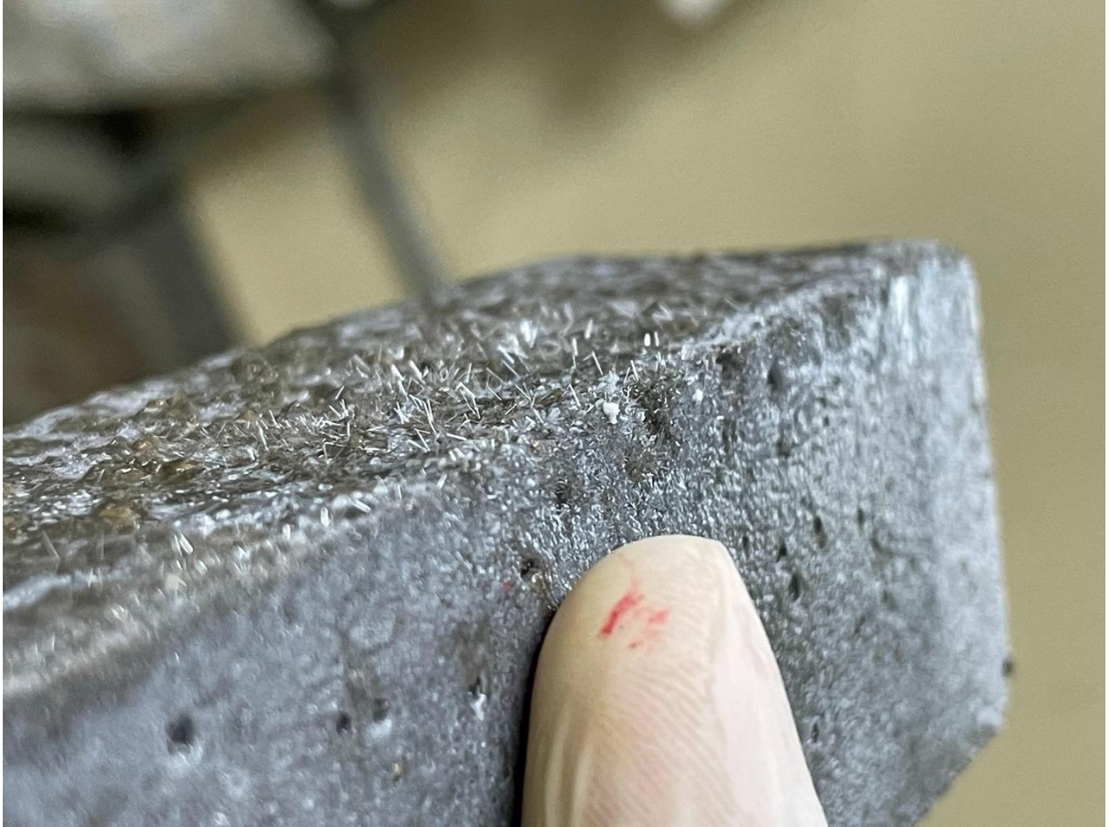
Figura 25 – Amostra da formação de cristais oriundos do ataque por sulfato na superfície do corpo de prova.
