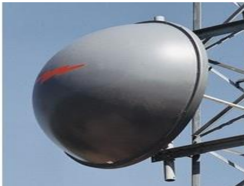
Figura 13- Exemplo de Radome molded
