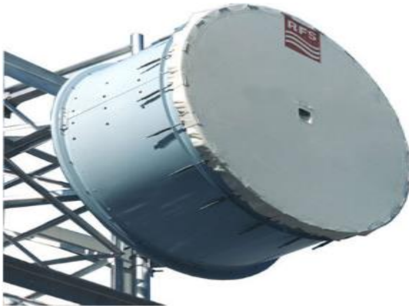
Figura 12 - Exemplo de Radome flexível
