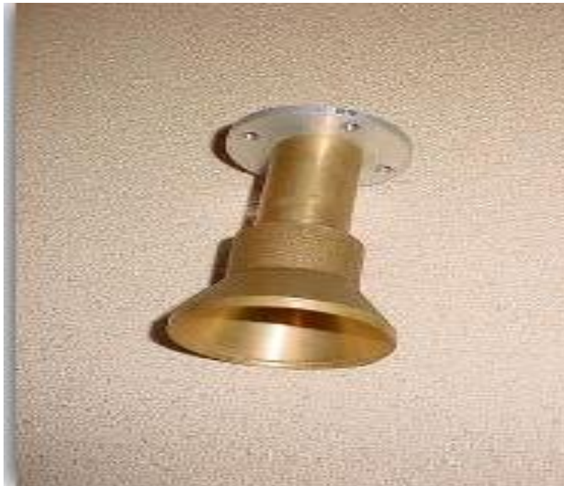
Figura 11 - Exemplo de Alimentador tipo corneta
