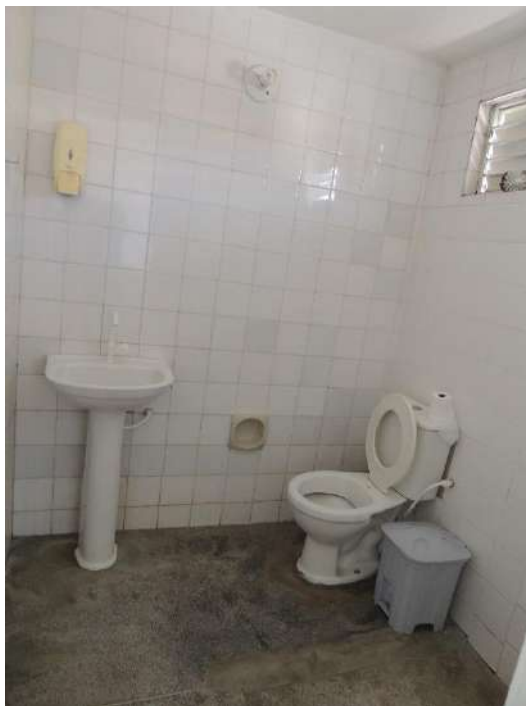
Figura 4 - Banheiro de Uso Exclusivo dos Profissionais na USF.
