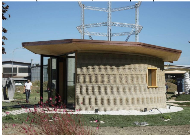
Figura 12 – Edificação chamada Gaia, construída pela impressora Crane Wasp .
