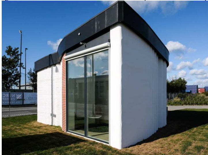
Figura 8 – Primeiro edifício construído com Impressão 3D na Europa.
