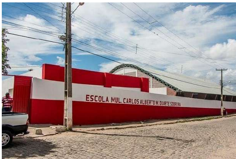
Figura 2 – Fachada da Escola Municipal Carlos Alberto Medeiros Duarte Sobreira. Fonte: Prefeitura de Princesa Isabel, Facebook, 2021.
