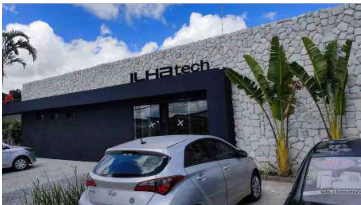
Figura 109 - Aplicação do letreiro na fachada Fonte: De autoria própria
