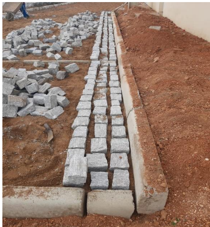
Figura 7 - Processo de execução
