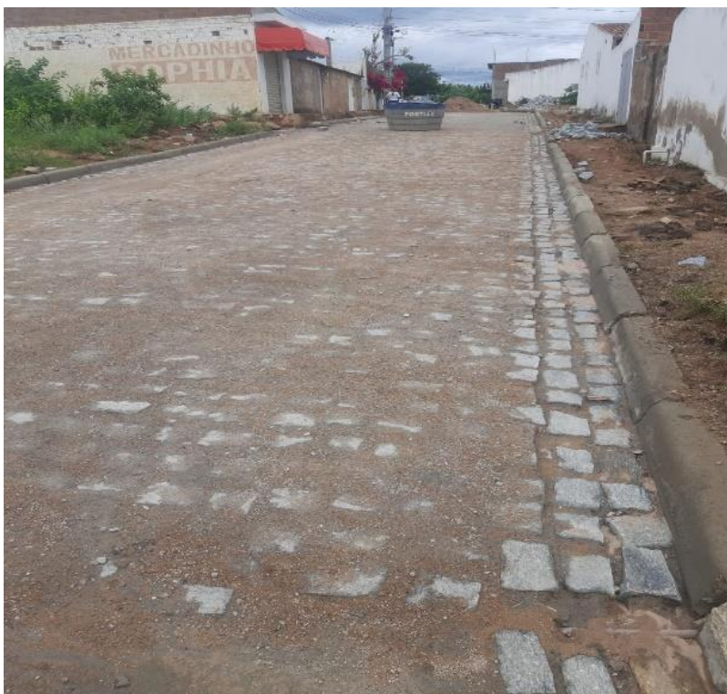
Figura 9 - Rejuntamento do calçamento
