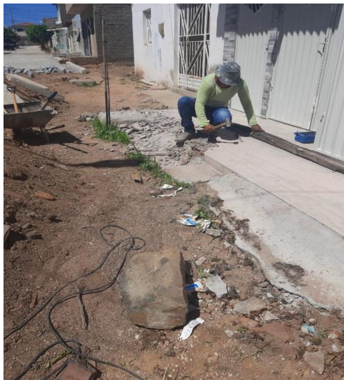
Figura 4 - Demolição da calçada para alinhamento do meio fio
