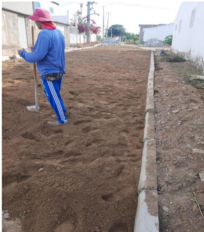
Figura 6 - Nivelamento do solo
