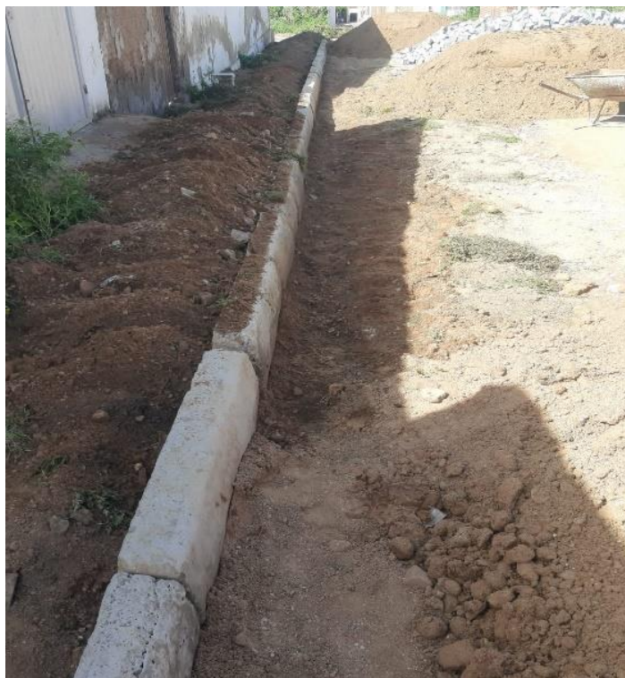
Figura 3 - Retirada do solo e aproveitamento para nivelamento da calçada
