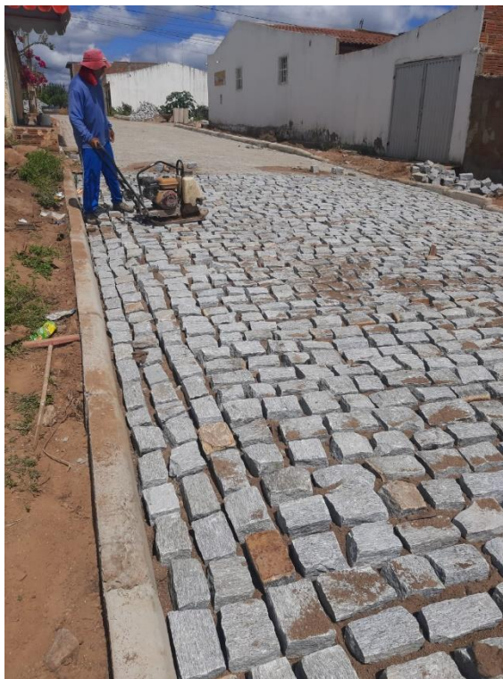
Figura 8 - Compactação do calçamento
