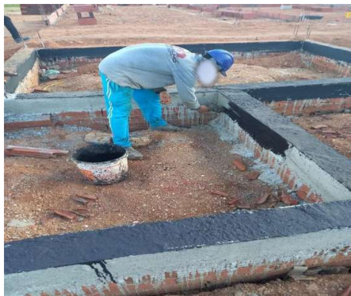
Figura 61 - Impermeabilização.
