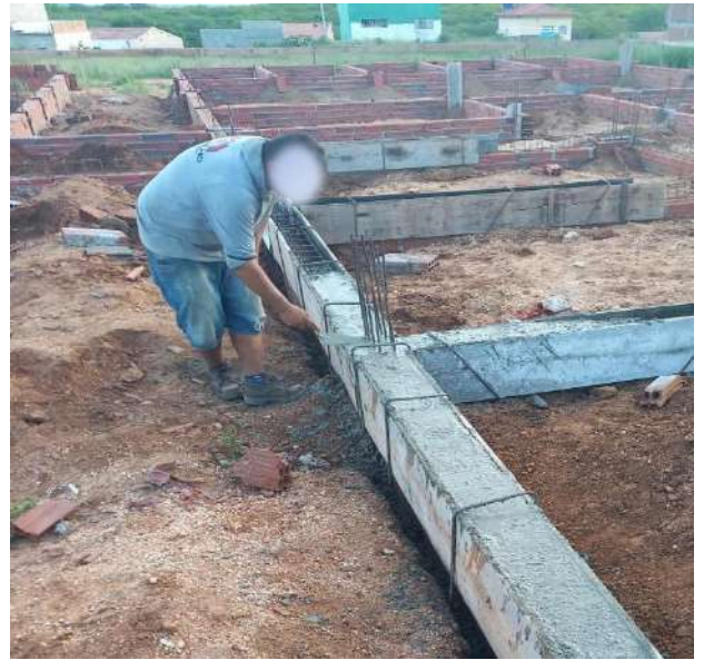
Figura 10 – Adensamento feito manualmente.
