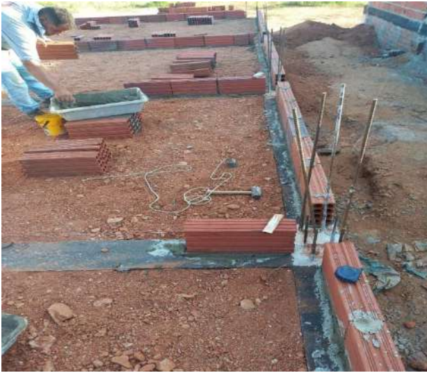
Figura 107 – Execução de alvenaria.
