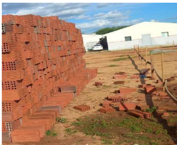
Figura 24 - Organização e limpeza do canteiro de obra.
