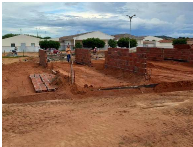
Figura 85 – Execução de aterro.
