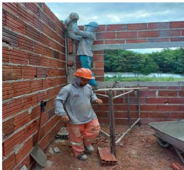
Figura 23 - Concretagem dos pilares.
