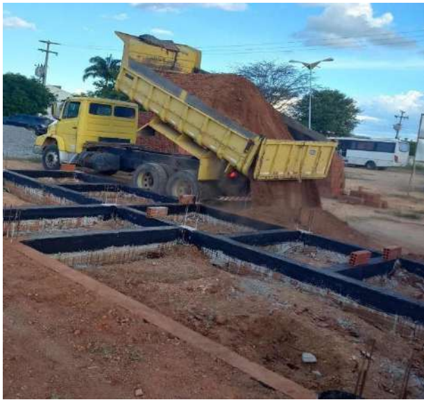
Figura 73 – Execução de aterro.
