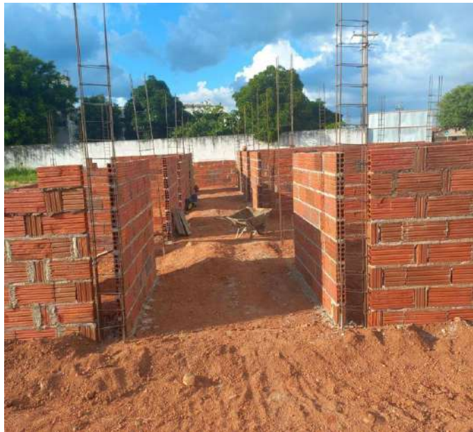
Figura 96 – Execução de alvenaria.
