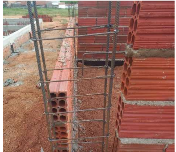
Figura 18 – Execução de alvenaria.
