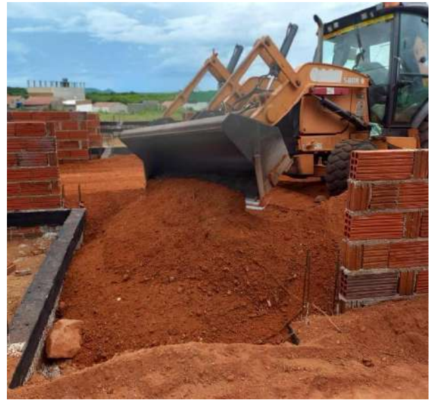
Figura 14 – Execução de aterro.
