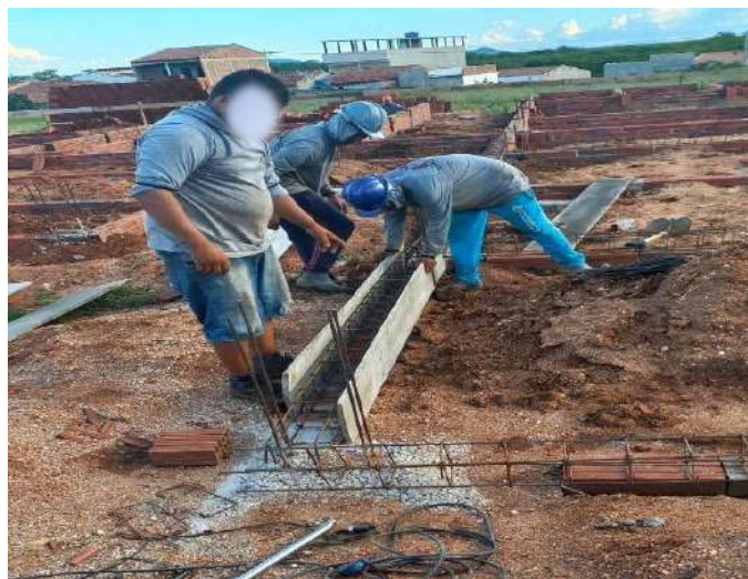
Figura 7 – Posicionamento das formas.
