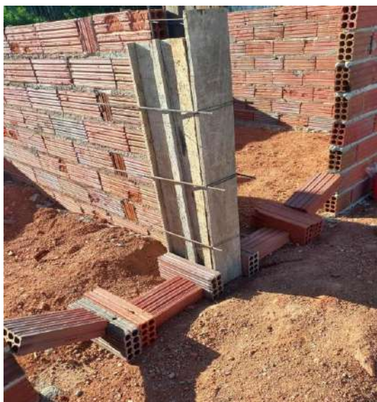
Figura 22 - Concretagem dos pilares.
