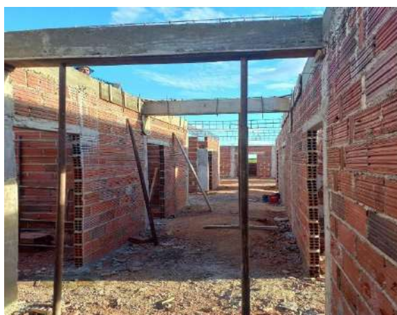
Figura 125 - Organização e limpeza do canteiro de obra.
