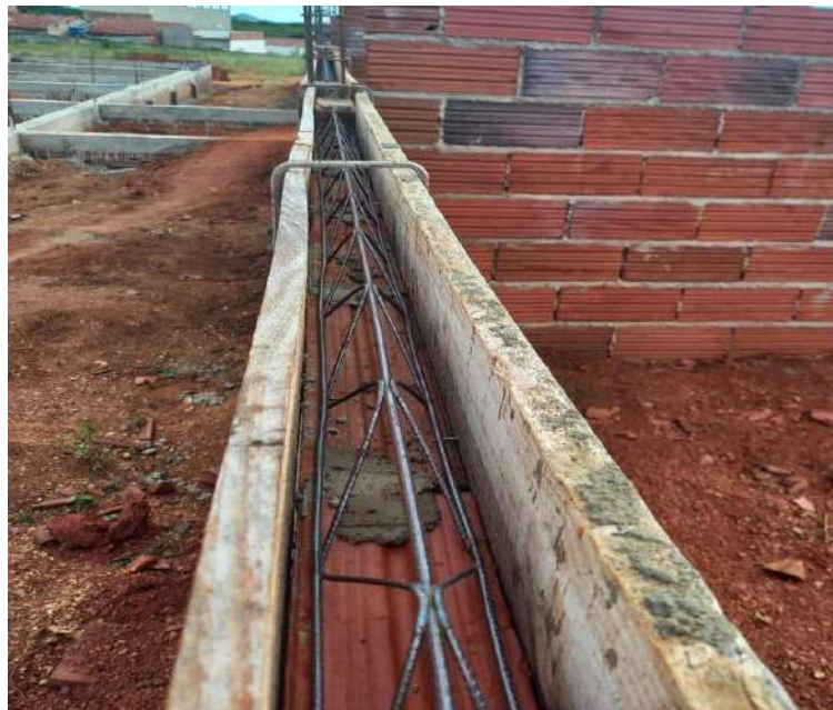
Figura 119 - Execução das vergas e contra vergas
