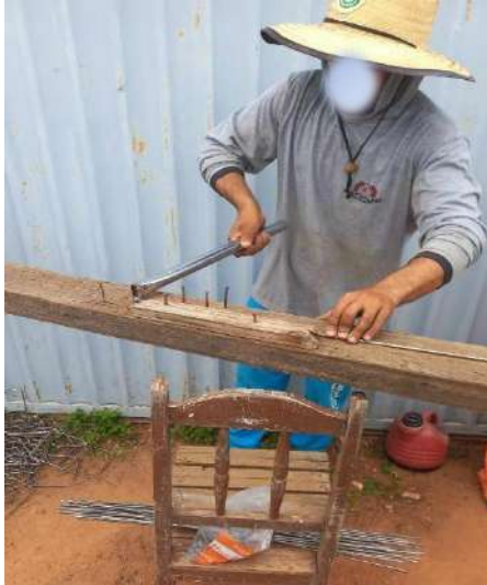
Figura 5 - Confeção de armaduras.
