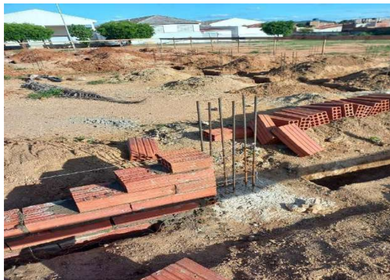
Figura 3 - Alvenaria de embasamento.
