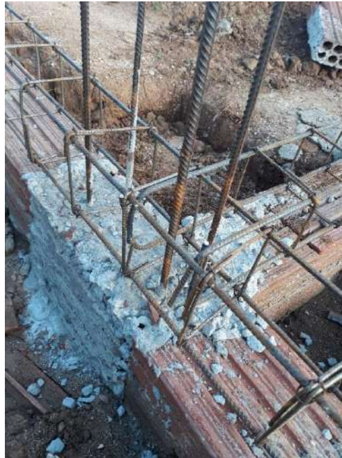
Figura 51 - Impermeabilização.
