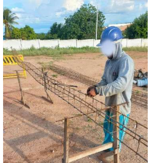
Figura 6 - Confeção de armaduras.
