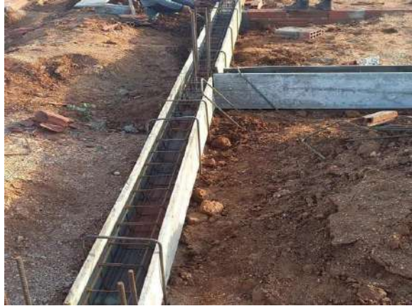
Figura 8 - Nivelamento da Fundação para execução da viga baldrame.
