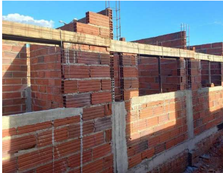
Figura 20 - Execução das vergas e contra vergas
