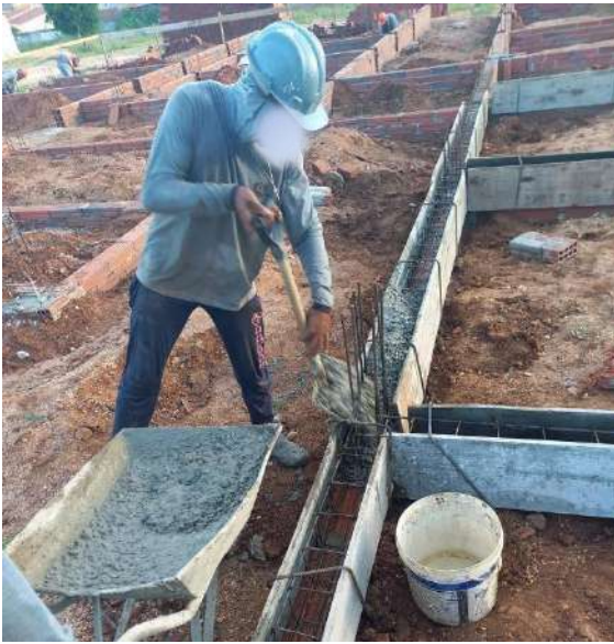
Figura 9 - Concretagem.
