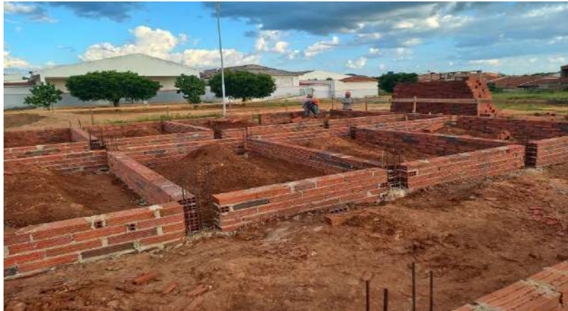
Figura 2 - Alvenaria de embasamento.
