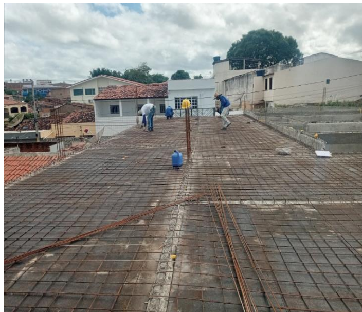
Figura 15 – Distribuição da Armadura
