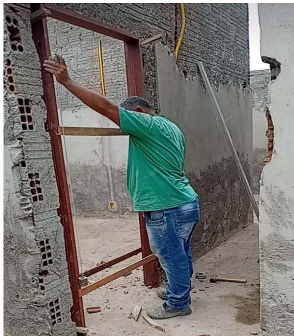
Figura 4 - Marcos sendo instalados
