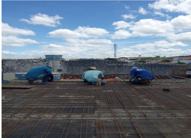
Figura 18 – Colocação das formas
