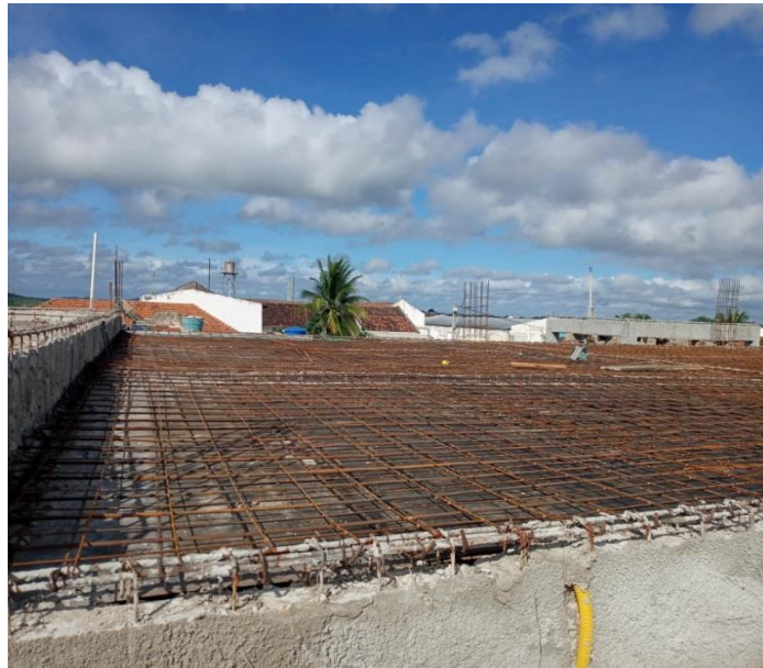
Figura 16 – Armadura da laje (telas)
