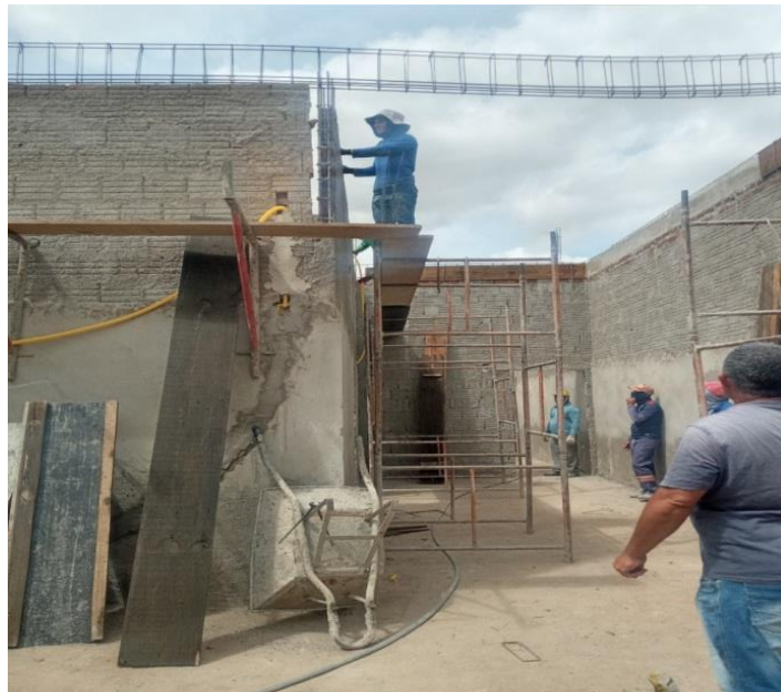
Figura 12 - Montagem da ferragem das vigas
