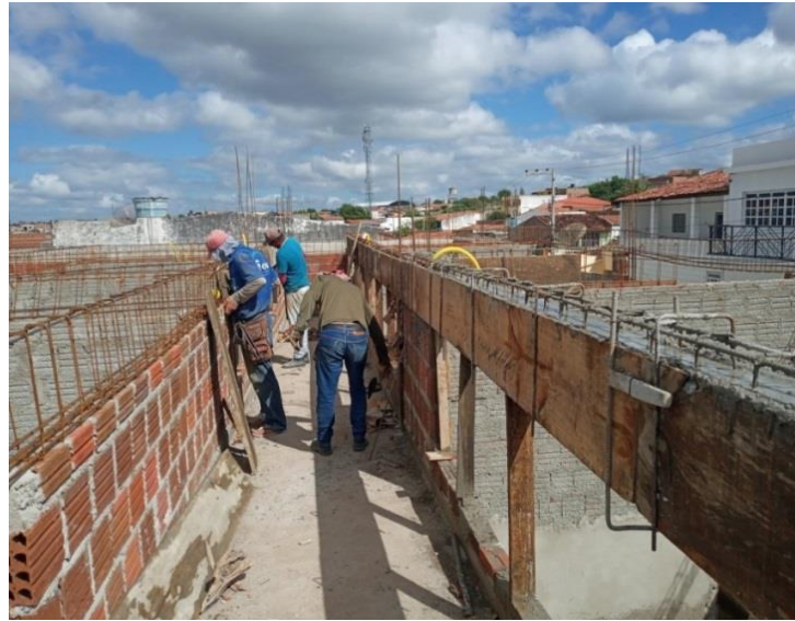
Figura 13 - concretagem das vigas
