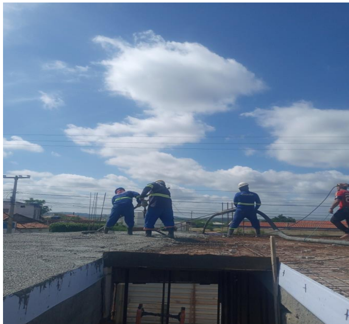
Figura 19 - Concretagem da laje
