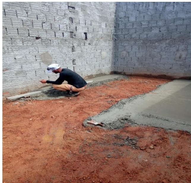
Figura 8 - Construção do contrapiso
