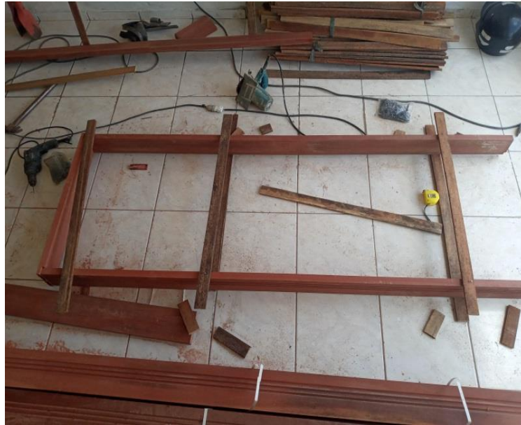
Figura 3 – Montagem dos marcos das portas
