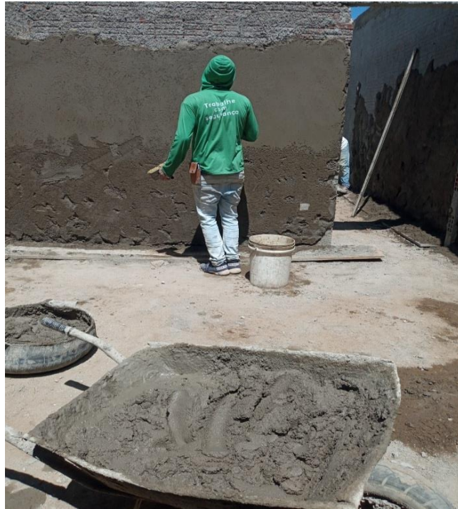
Figura 9 - Revestimento da alvenaria
