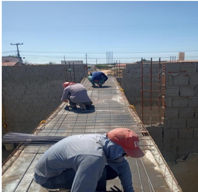
Figura 10 - Armação da malha
