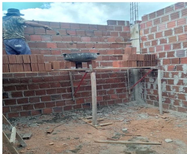
Figura 1 - Levantamento da alvenaria
