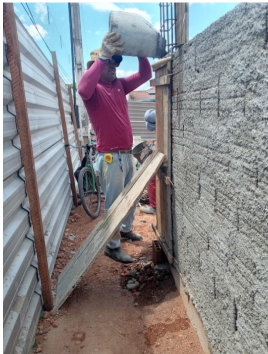
Figura 2 - Concretagem dos pilares
