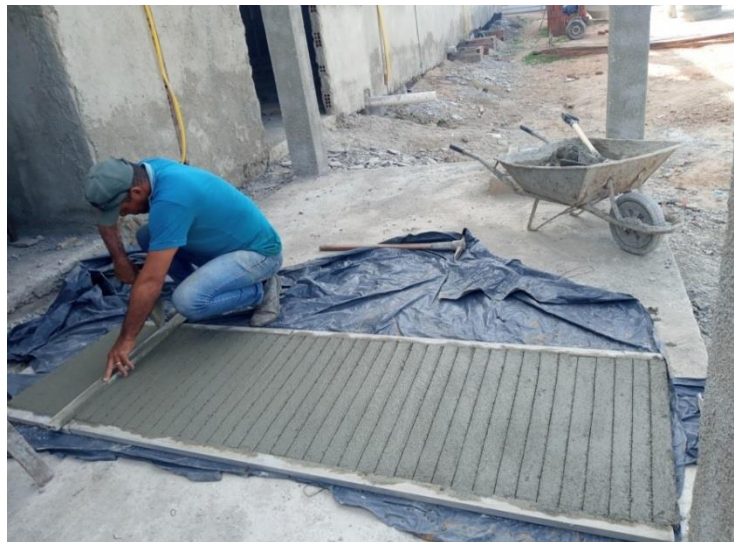
Figura 17 - Espaçadores de cimento (cocadas)
