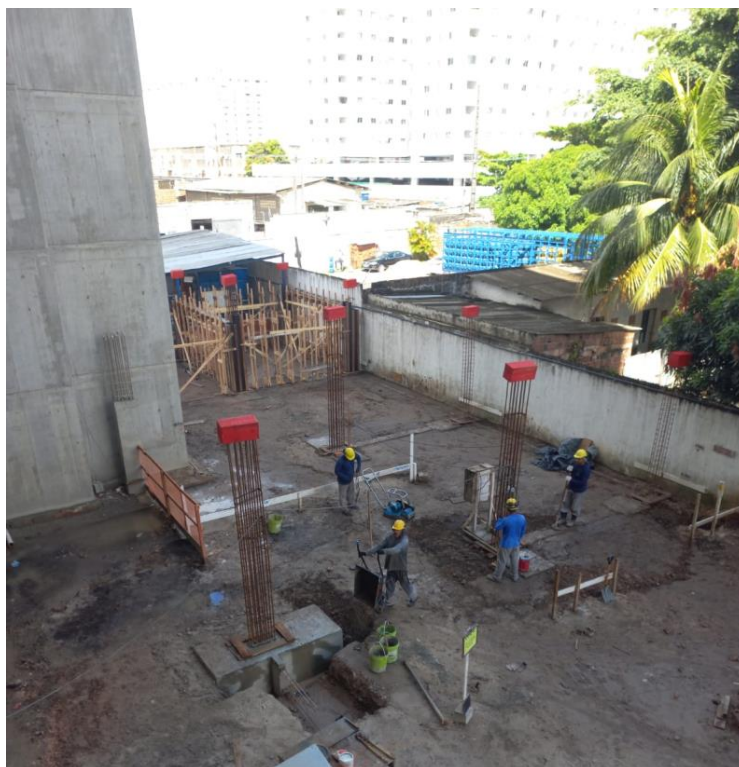
Figura 13 - Fundação do edifício garagem da Obra A
