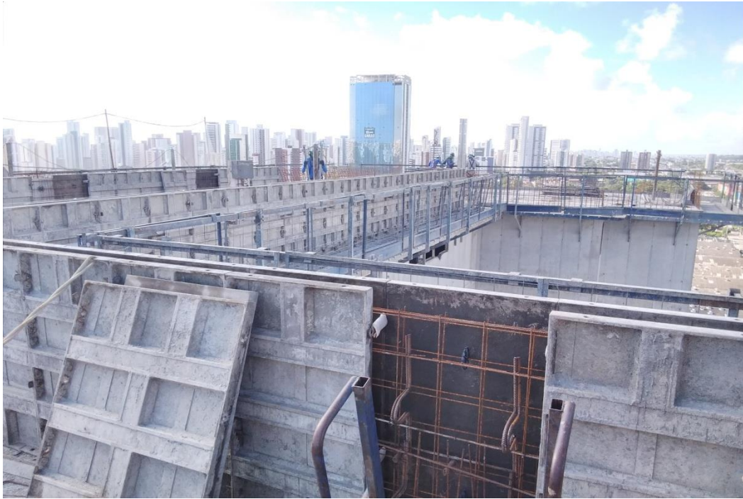
Figura 15 – Sistema de parede de concreto moldada “in loco”
