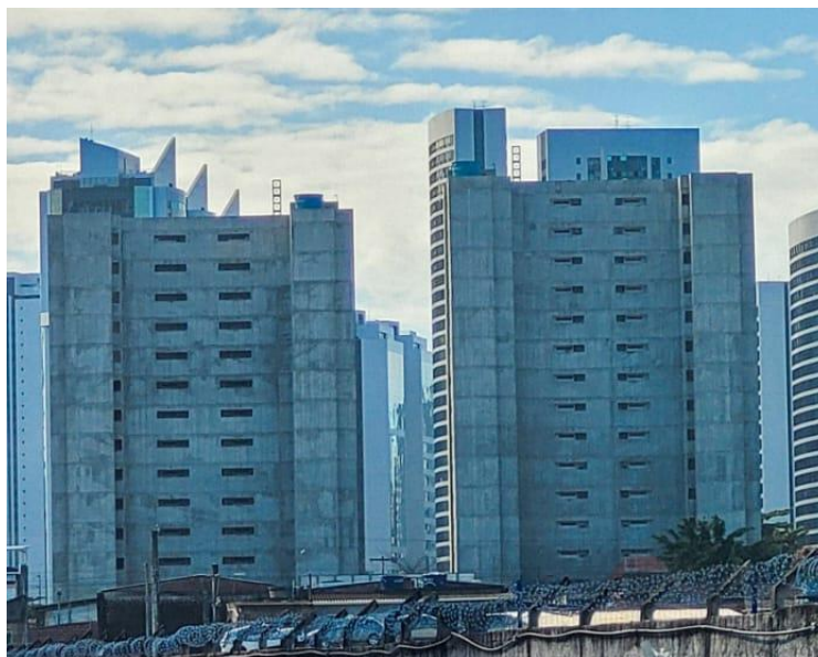
Figura 14 - Torre 1 e 2 dos edifícios de apartamentos da Obra A
