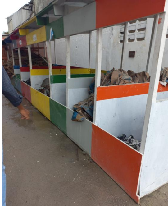
Figura 19 – Baias de coleta seletiva da obra A
