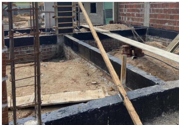
Figura 18 – Impermeabilização das vigas
