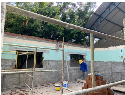
Figura 7 – Cinta de amarração com canaletas
