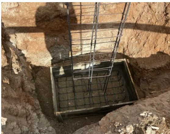
Figura 12 – Grelha, amarração do pilar e forma
