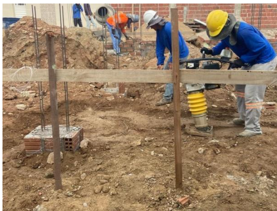
Figura 15 – Compactação de placas
