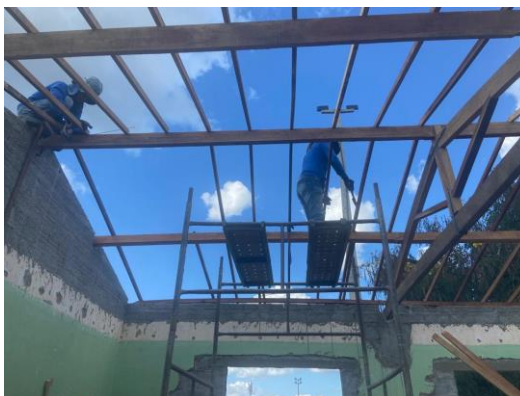
Figura 8 – Execução de cobertura
