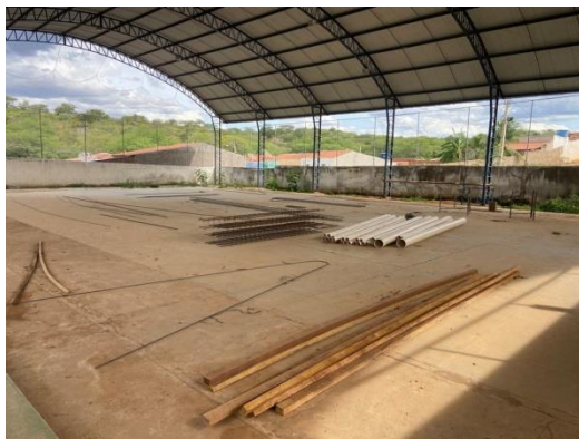
Figura 2 – Armazenagem de materiais na quadra
