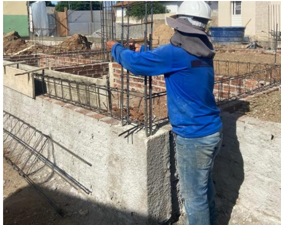
Figura 17 – Montagem de formas
