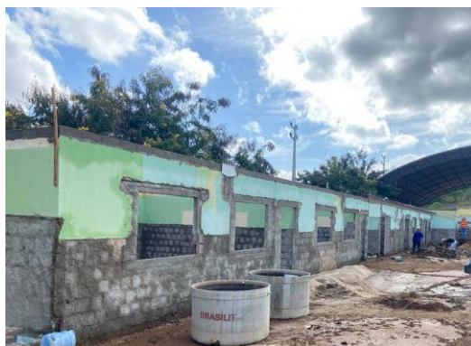
Figura 6 – Vergas e contravergas de janelas e portas
