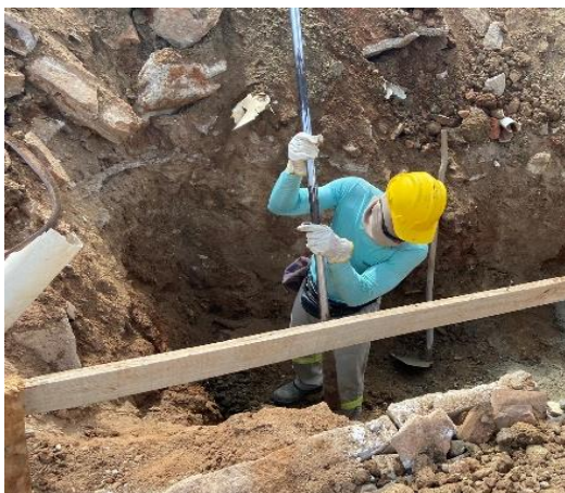
Figura 11 – Escavação da vala
