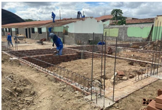
Figura 16 – Posicionamento das armaduras
