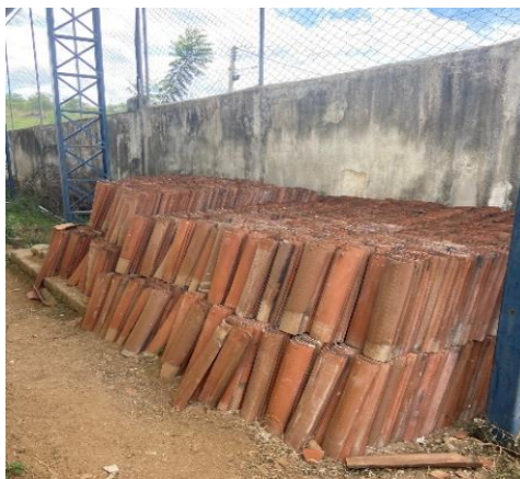
Figura 3 – Telhas armazenadas na quadra
