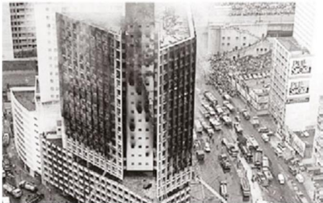
Figura 1 - Edifício Joelma Capital Paulista
