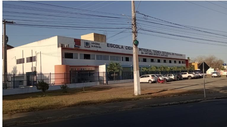
Figura 01 - Escola Cidadã Integral Técnica Estadual de Ensino Fundamental e Médio Dr° Antônio Batista Santiago
