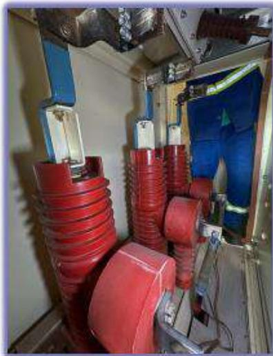
Figura 5: Disjuntor geral de alta tensão.
