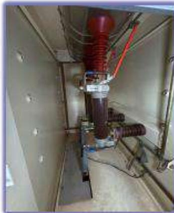
Figura 6: Seccionadora tripolar K8.
