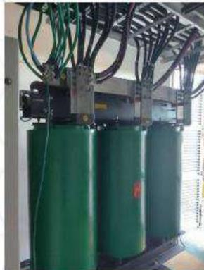
Figura 5: Vista lateral do transformador 3 depois da manutenção.
