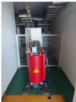
**Descrição:** Transformador a seco, de 1000 kVA, 13,8/0,38kV, fabricante ABB, número de série: 10581.
