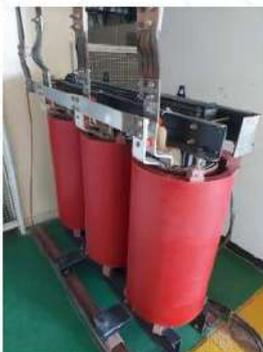
Figura 4: Vista superior do transformador 2 depois da manutenção.
