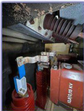
Figura 9: Transformadores de potencial da proteção geral.
