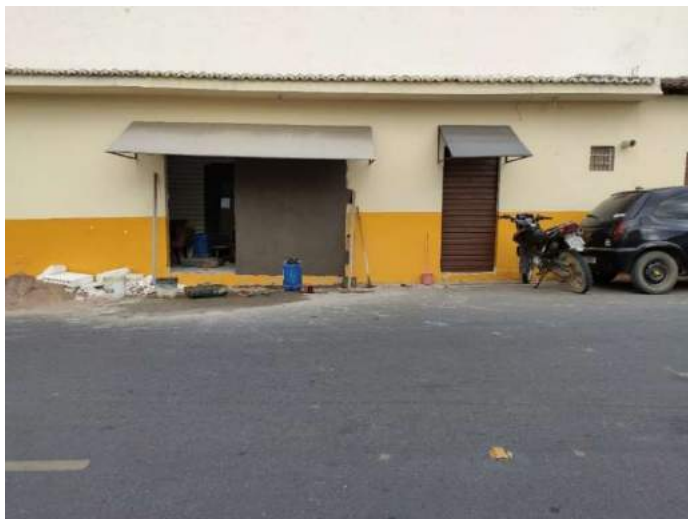
Figura 19 – Reforma Em Box Da Fachada Oeste
