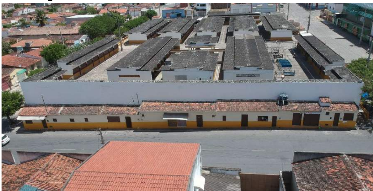
Figura 13 – Fachada Oeste do Mercado Público de Pocinhos-PB
