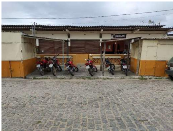
Figura 18 – Motos Na Calçada Da Fachada Sul
