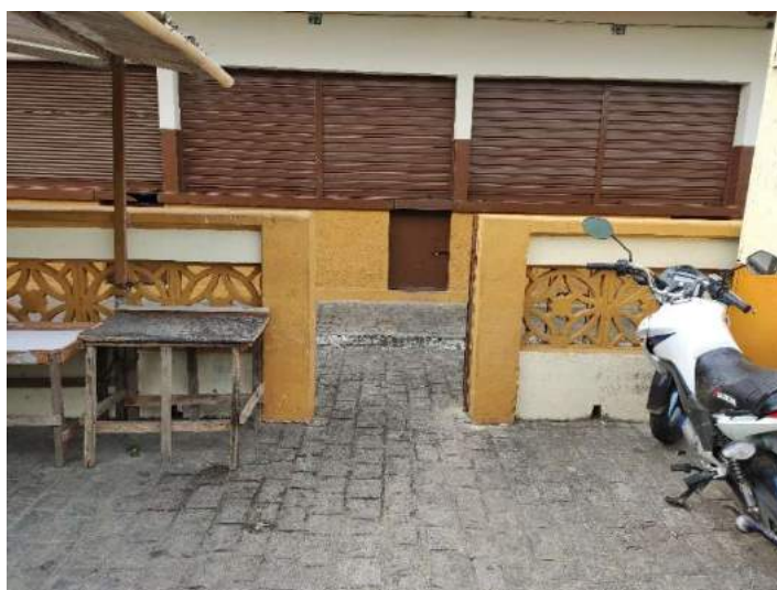
Figura 24 – Portão De Acesso, Fachada Sul
