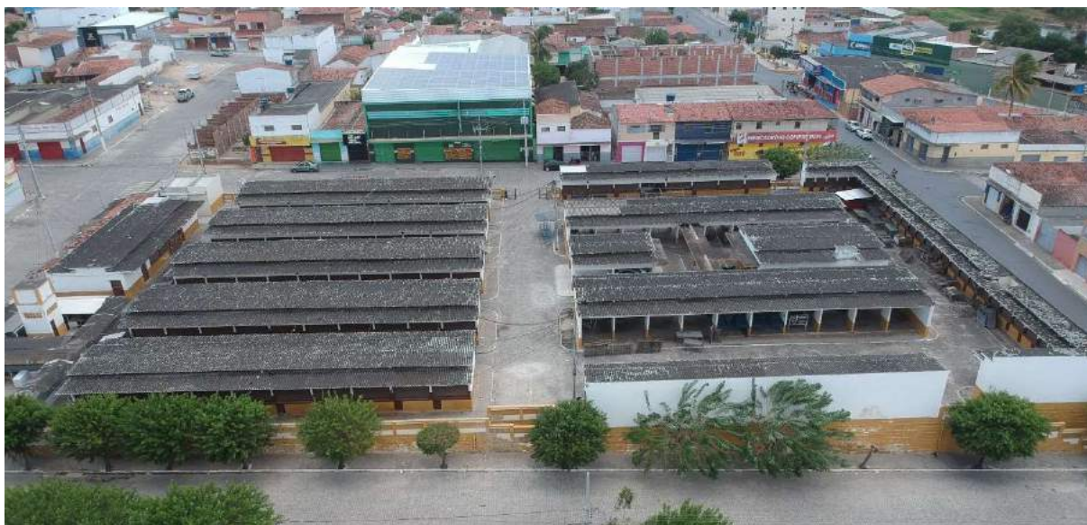
Figura 12 – Fachada Norte do Mercado Público de Pocinhos-PB
