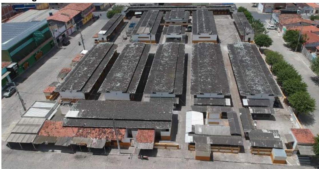
Figura 11 – Fachada Leste do Mercado Público de Pocinhos-PB
