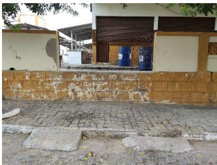
Figura 29 – Portão De Carga E Descarga
