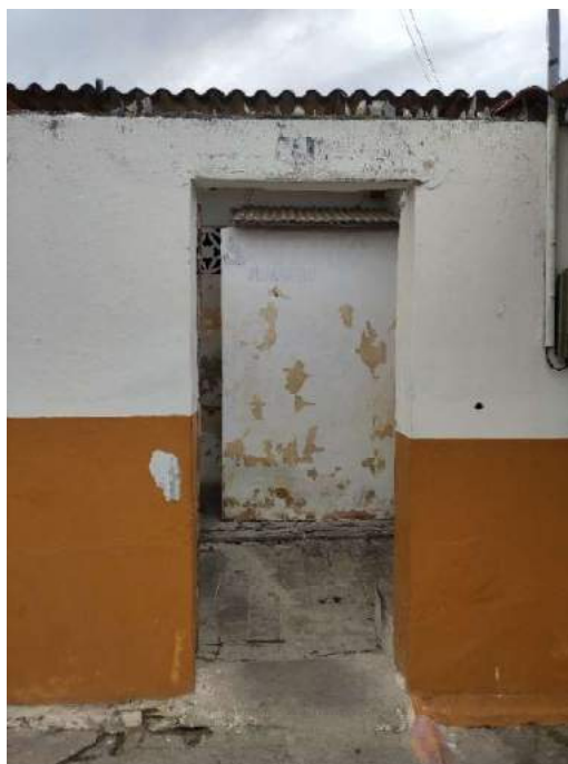
Figura 23 – Portão De Acesso Ao Banheiro Feminino
