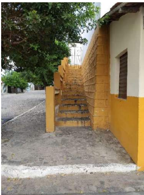
Figura 27 – Escada De Pedras, Fachada Oeste
