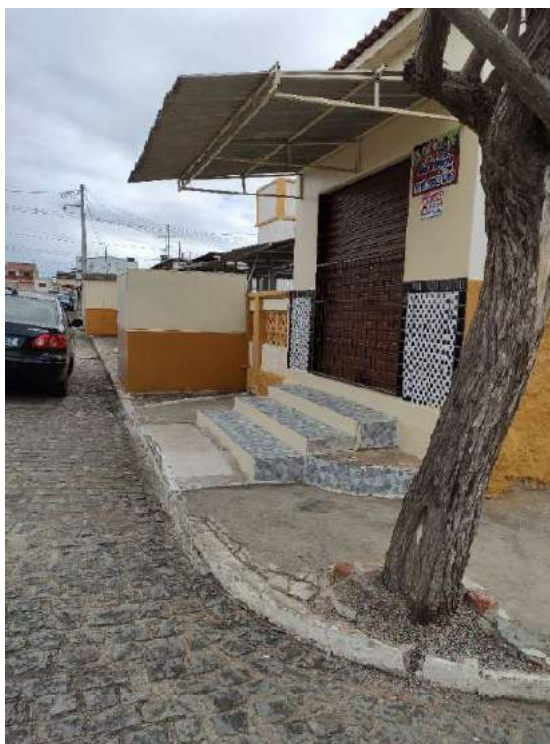
Figura 15 – Calçada Fachada Leste
