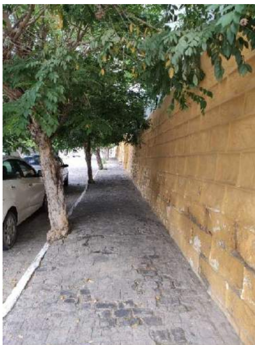
Figura 20 – Calçada Da Fachada Norte
