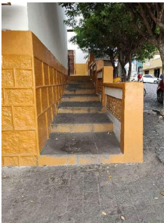
Figura 26 – Escada De Acesso 1, Fachada Oeste
