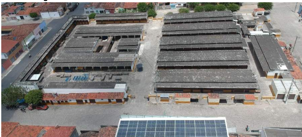
Figura 14 – Fachada Sul do Mercado Público de Pocinhos-PB
