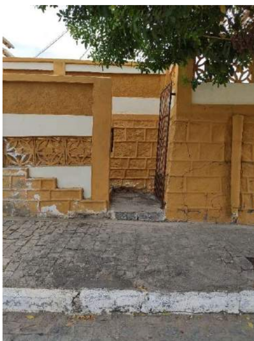
Figura 28 – Escada Da Fachada Norte
