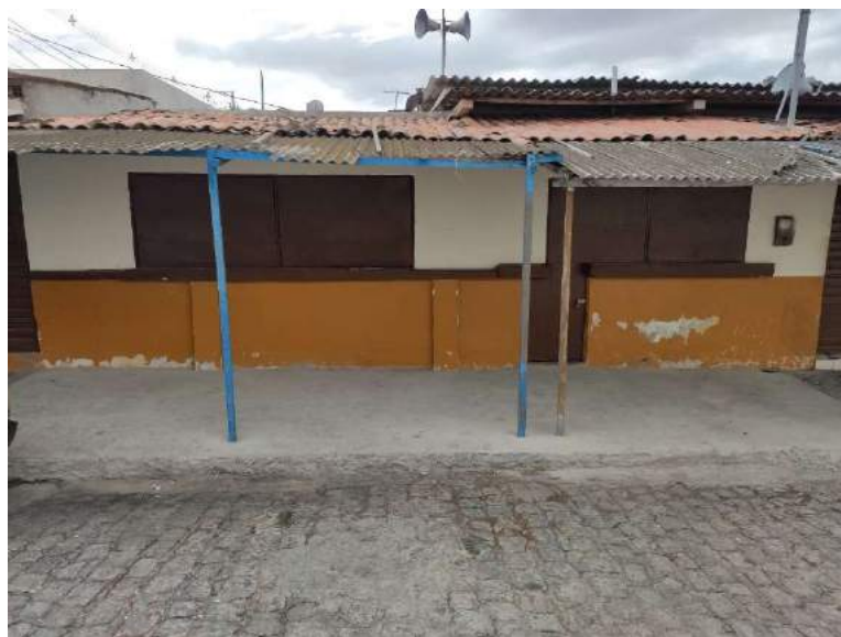
Figura 16 – Cobertura de Barracas Fachada Leste
