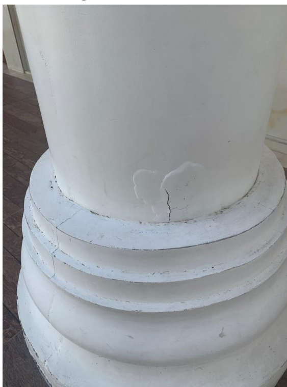
Figura 11 – P1 (Fissura)
