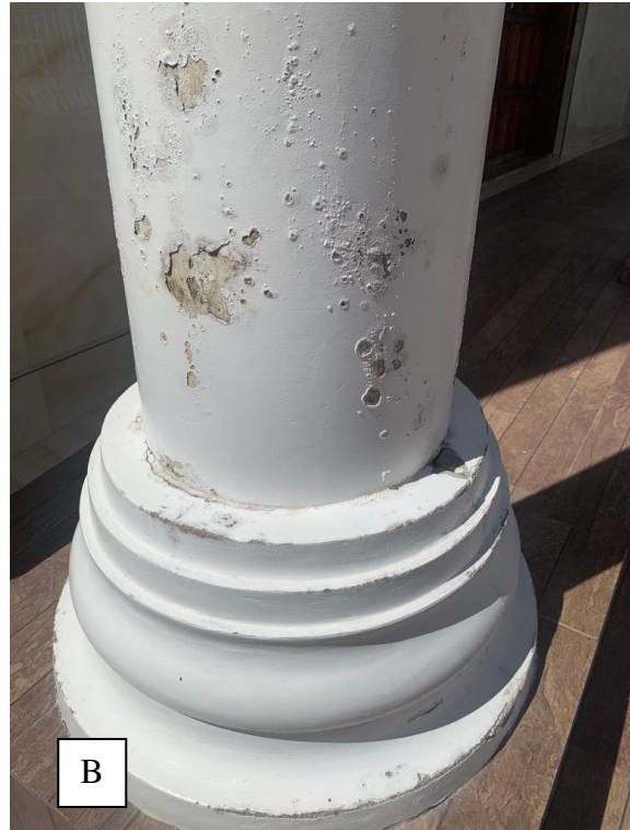
Figura 14 – P4 (Eflorescências, Fissuras e trincas)
