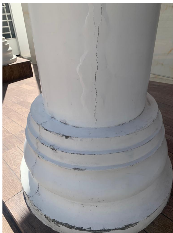
Figura 13 – P3 (Fissura)
