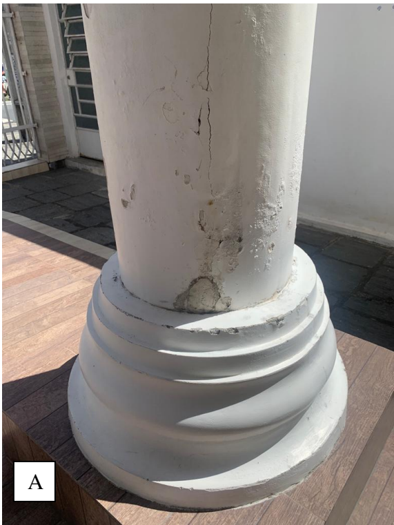
Figura 14 – P4 (Eflorescências, Fissuras e trincas)
