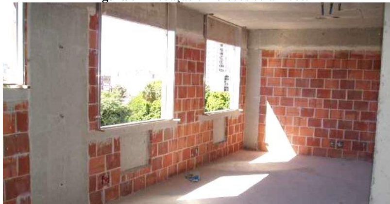
Figura 5 - Vedação em blocos cerâmicos.
