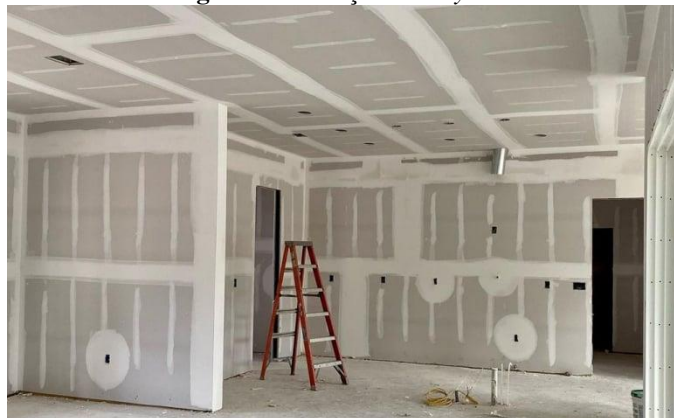
Figura 6 - Vedação em drywall .
