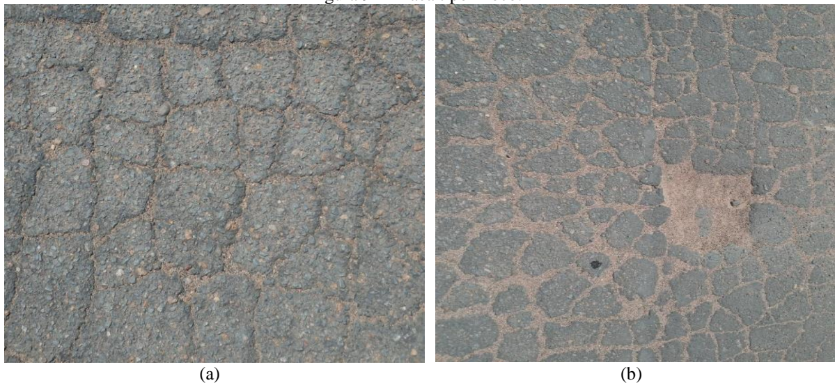
Figura 9-Trinca tipo Bloco.
