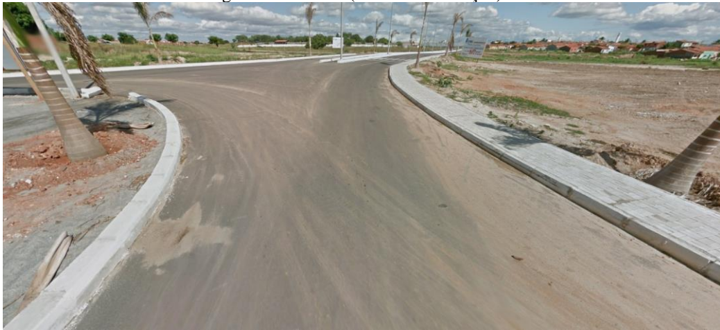
Figura 3 - Passado (em fase construção).
