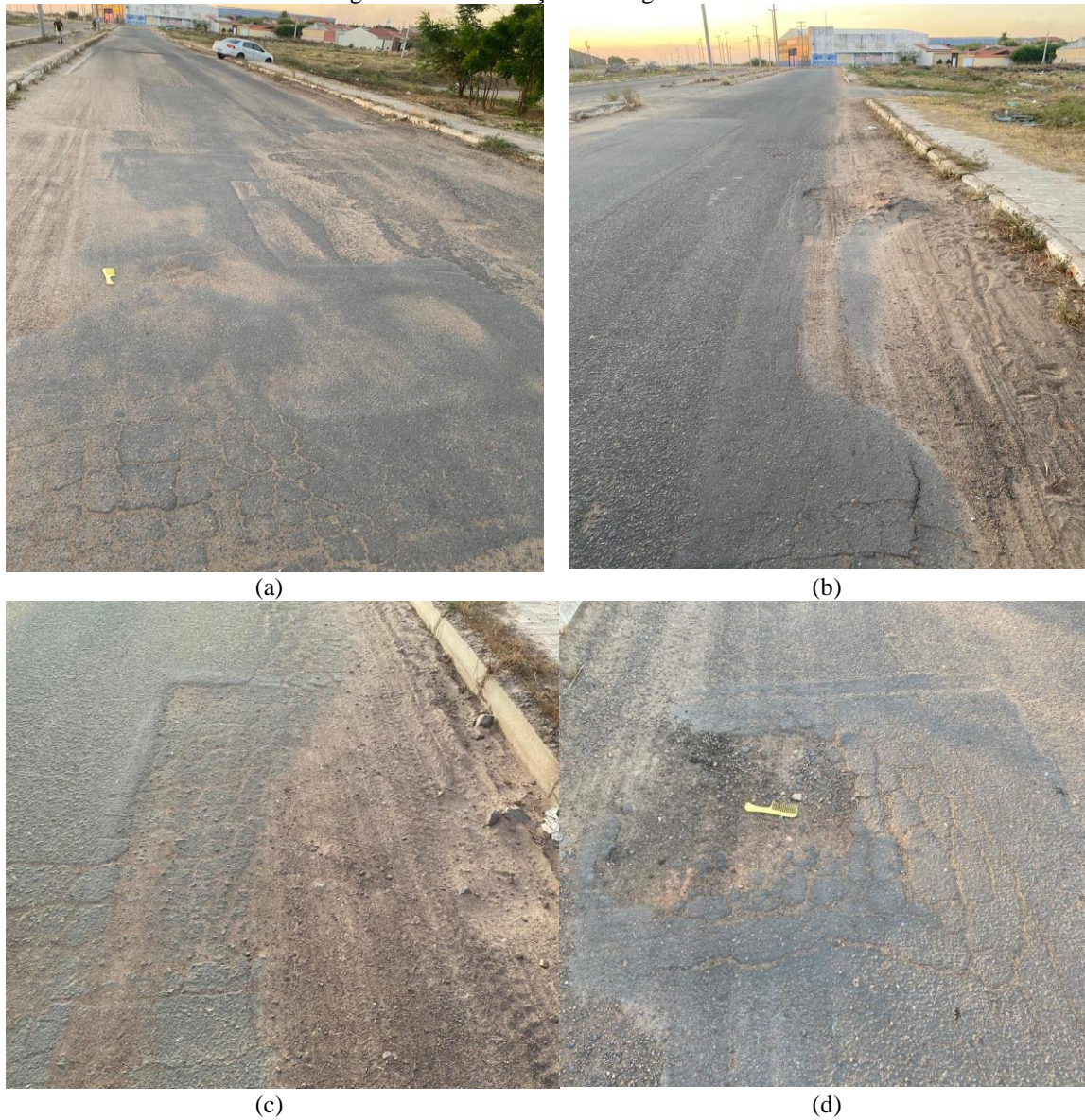
Figura 11-Manifestação Patológica: Remendo.
