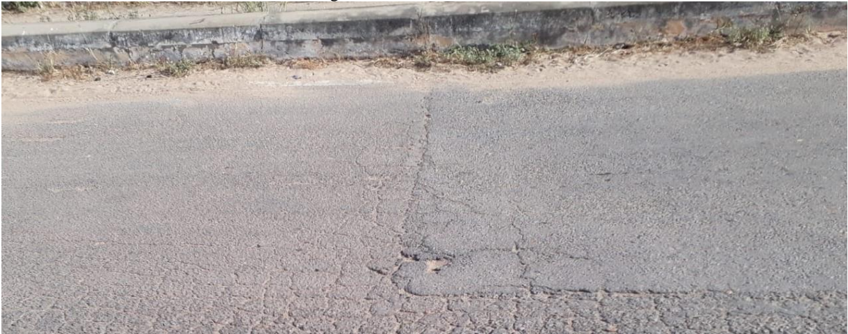
Figura 8 – Trinca transversal.
