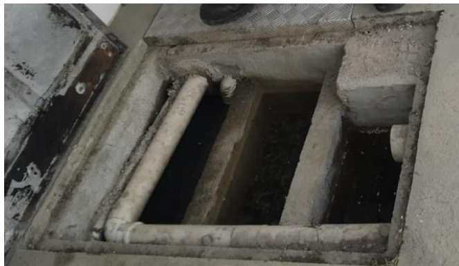
Figura 14: Parte interna do filtro por decantação
