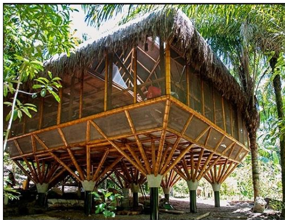
Figura 15: Exemplo de Estrutura em bambu
