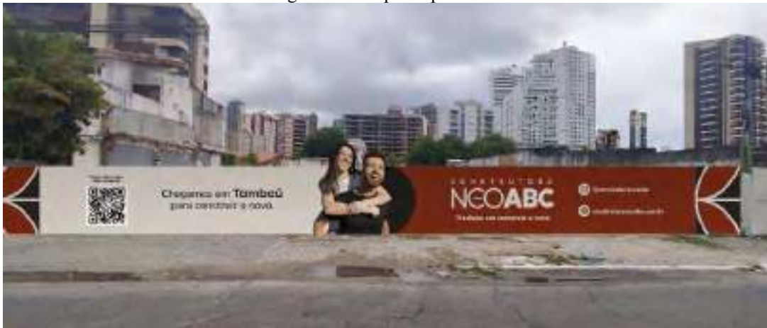
Figura 49 – Tapume para obra
