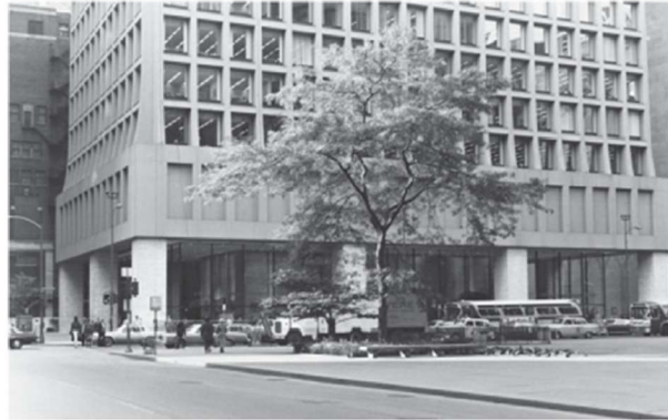
Figura 2.2.1 – Viga-parede contínua em fachada de edifício.
