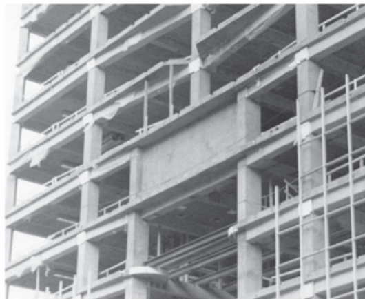
Figura 2.2.2 – Viga-parede de transição.
