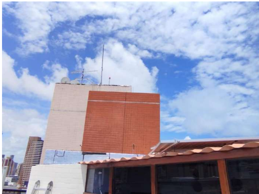
Figura 8 - Caixa d'água localizada a 4 metros de distância dos módulos
