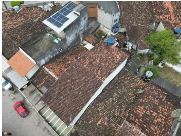
Figura 27 – Imagem de drone do local de instalação
