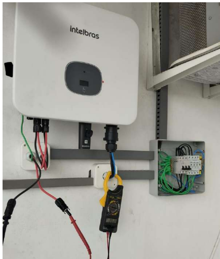
Figura 38 – Medição da tensão de entrada CC do inversor
