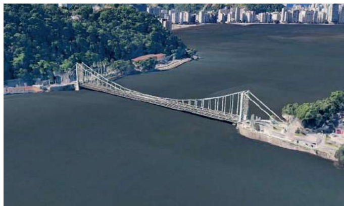
Figura 1.11 – Ponte Pênsil de São Vicente
