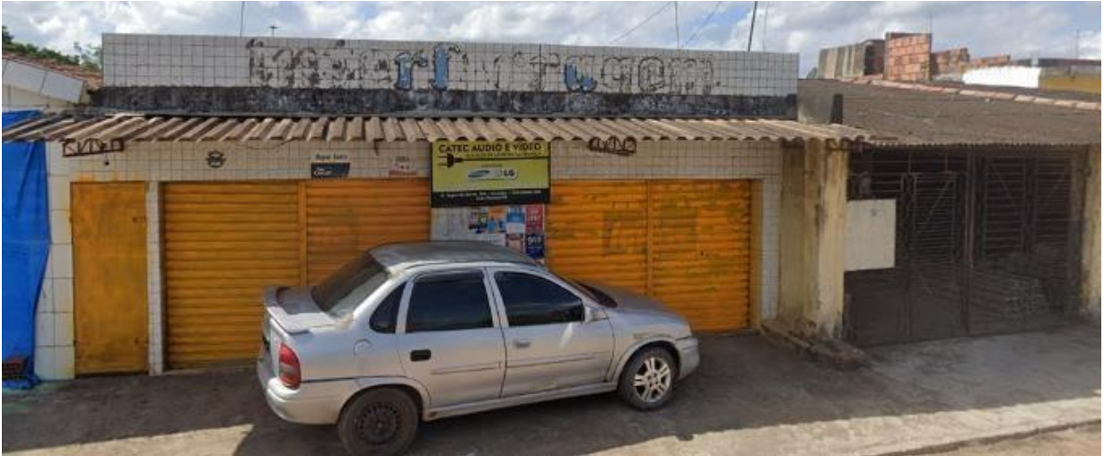
Figura 4: Fachada da interferragens.
