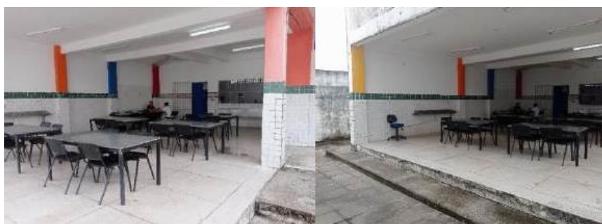
Figura 5: Refeitório da Escola Campo, Bayeux-PB. 2022.
