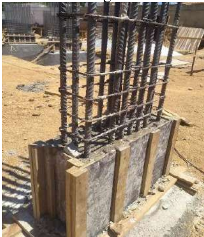
Figura 18: Concretagem da base do pilar.
