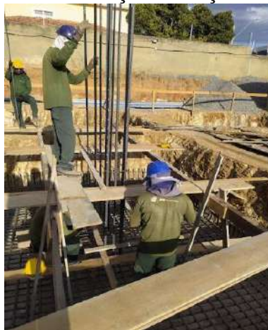
Figura 19: Armação e locação de pilar.
