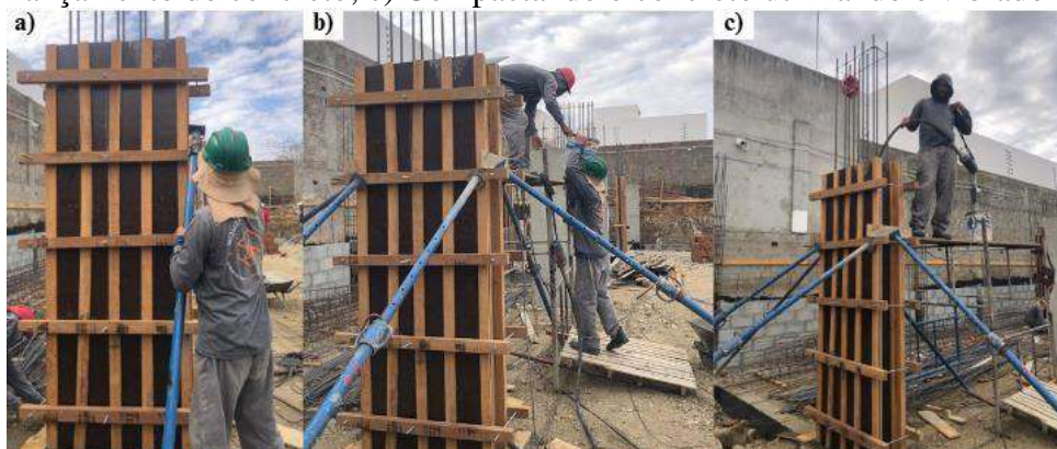
Figura 11: Concretagem dos pilares: a) Colocando escoras nos pilares; b) Iniciando o lançamento do concreto; c) Compactando o concreto utilizando o vibrador.
