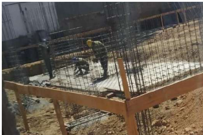
Figura 16: Armação de corte e dobra do aço para viga do poço do elevador.
