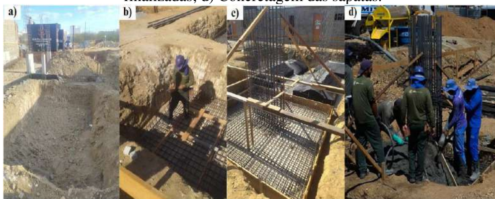
Figura 15: Execução da fundação do tipo sapata: a) Escavação do solo; b) Preparação das bases das sapatas colocando a armadura acima do concreto magro; c) Armaduras já finalizadas; d) Concretagem das sapatas.
