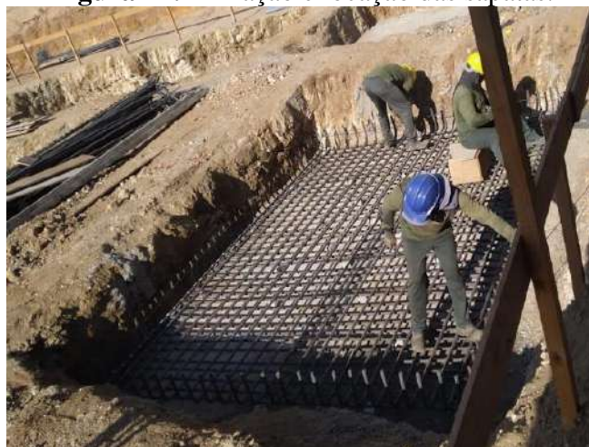
Figura 17: Armação e locação das sapatas.
