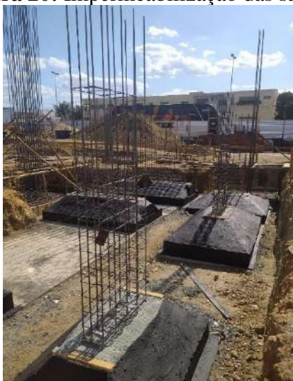
Figura 20: Impermeabilização das sapatas.
