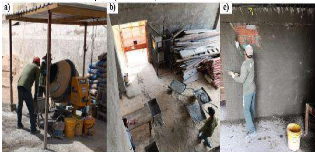
Figura 5: Aplicação do chapisco em alvenaria: a) preparação da argamassa na betoneira no pavimento térreo; b) Transporte vertical da argamassa até o pavimento do 15º andar; c) Aplicação do chapisco na alvenaria.
