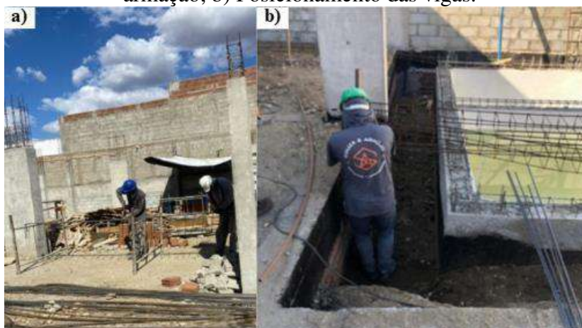
Figura 12: Montagem e posicionamento das armaduras para as vigas: a) Montagem da armação; b) Posicionamento das vigas.
