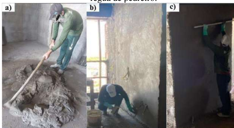
Figura 6: Aplicação do reboco em alvenaria: a) preparação da argamassa; b) Aplicação da argamassa na alvenaria utilizando a colher de pedreiro; c) nivelamento da alvenaria com a régua de pedreiro.
