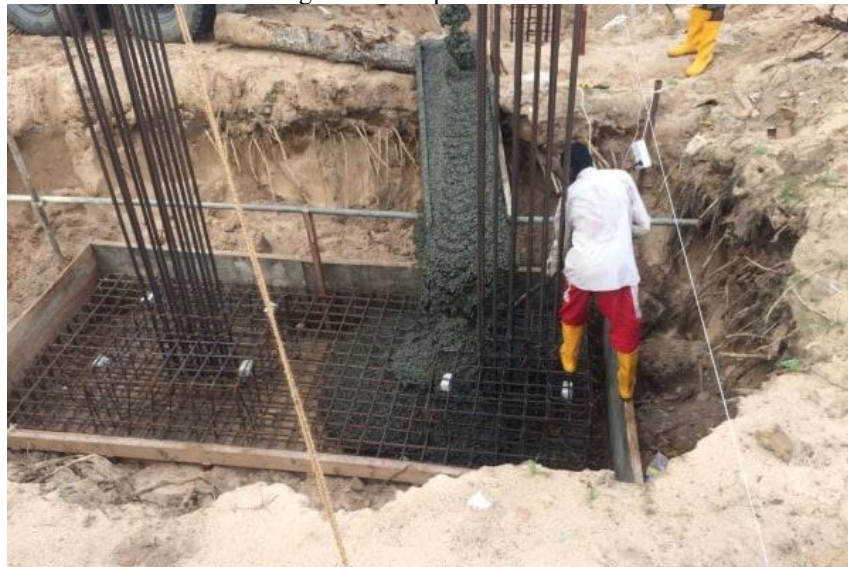
Figura 03 – Sapata associada
