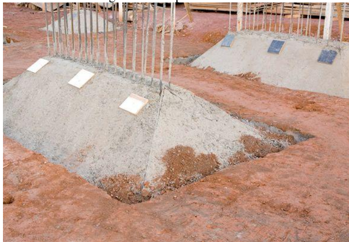
Figura 05 – Sapata alavancada
