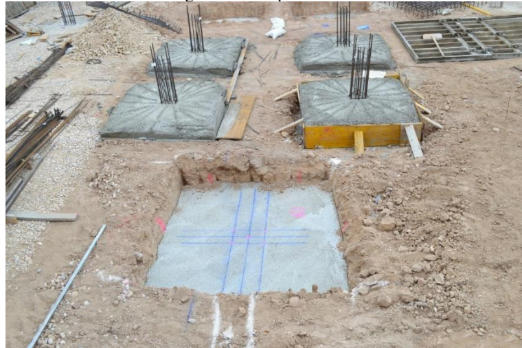
Figura 02 – Sapata isolada
