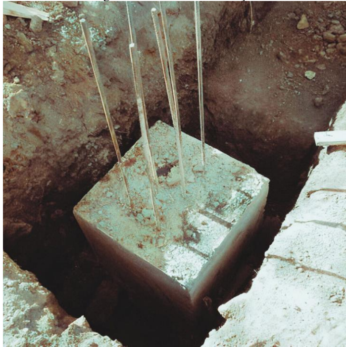
Figura 01 – Bloco de Fundação
