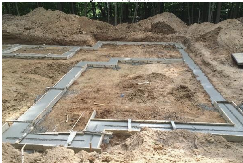
Figura 04 – Sapata corrida
