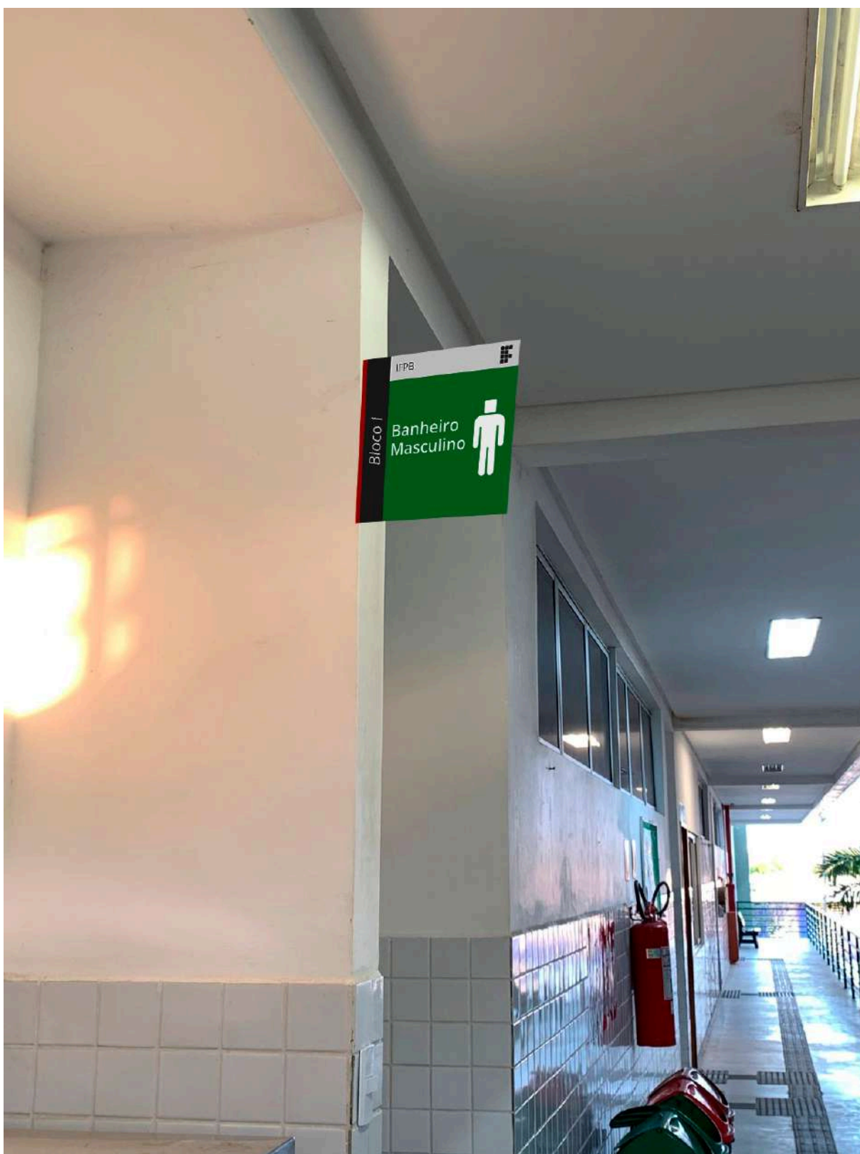
Figura 45: Implementação placa na parede (Banheiro) - Primeiro pavimento
