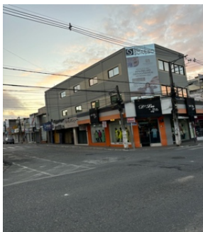
FIGURA 01: Vista Frontal do Edifício
