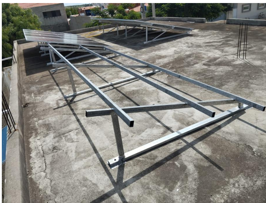
Figura 6 – Estrutura para fixação de módulos em laje.
