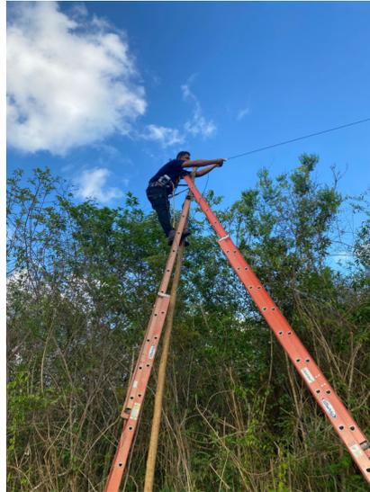
**Figura 4.3:** *Substituição de fibra óptica danificada por ação de queimadas.*
