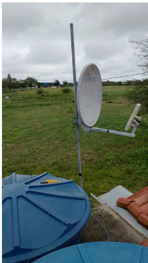
**Figura 4.6:** Antena de rádio utilizada como alternativa à fibra óptica na zona rural.
