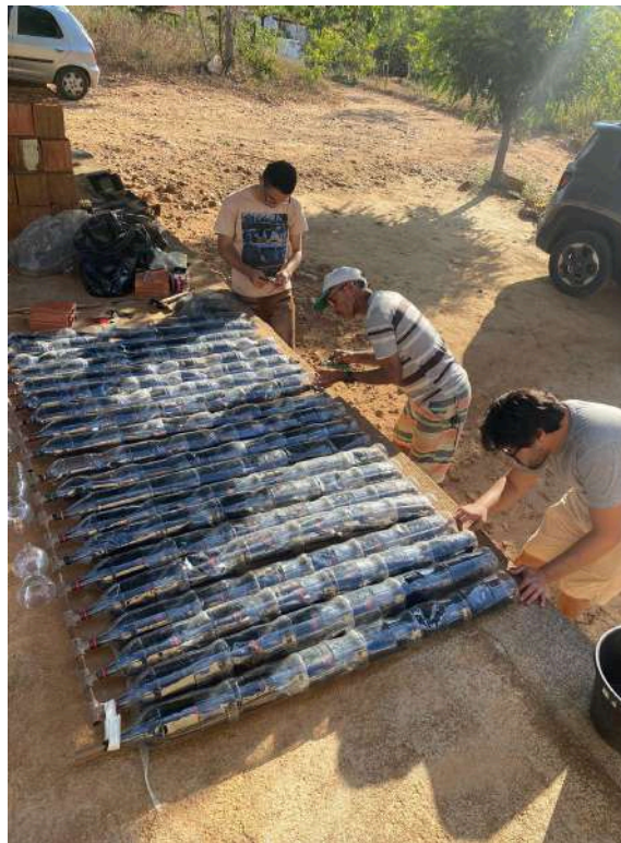
Figura 5 - Construção do aquecedor solar de garrafas PET.
