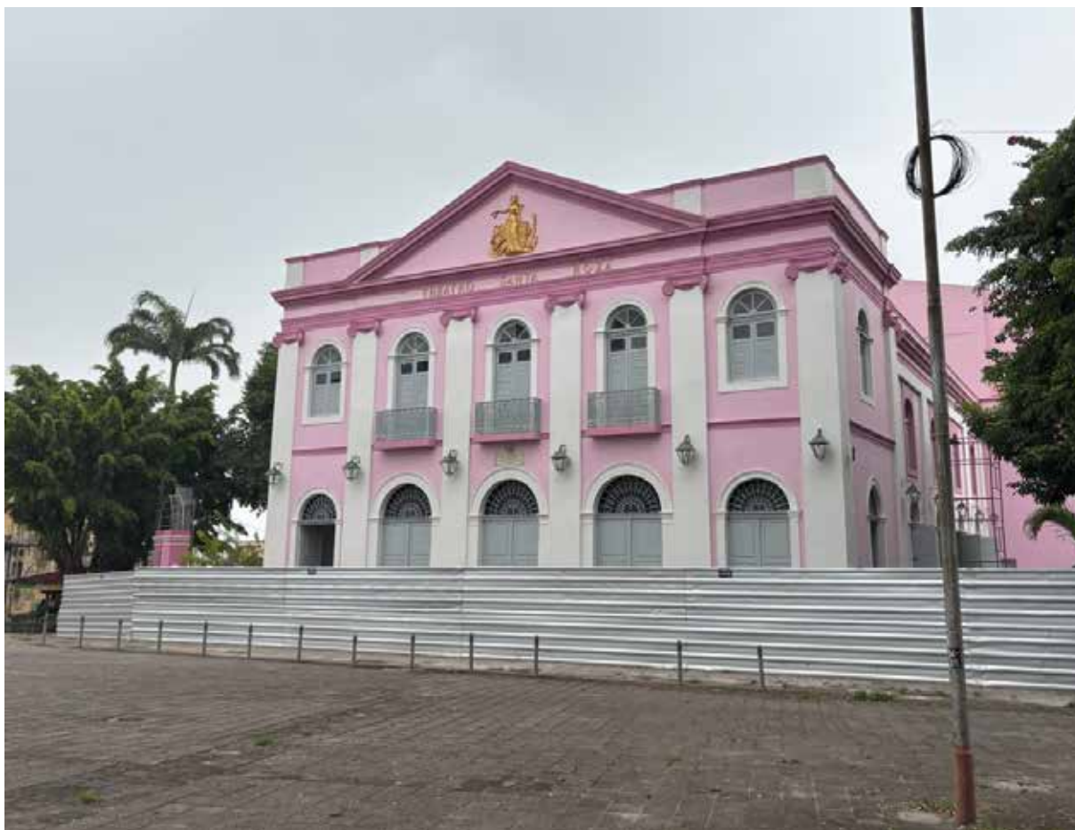
Figura 11: Sinalização existente Teatro Santa Roza
