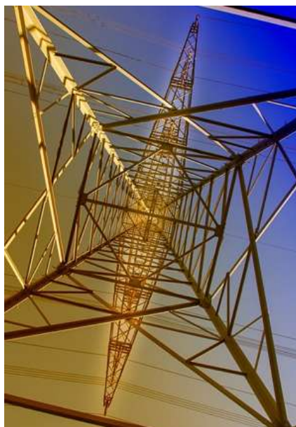
Figura 4 – Visão inferior de uma torre elétrica.
