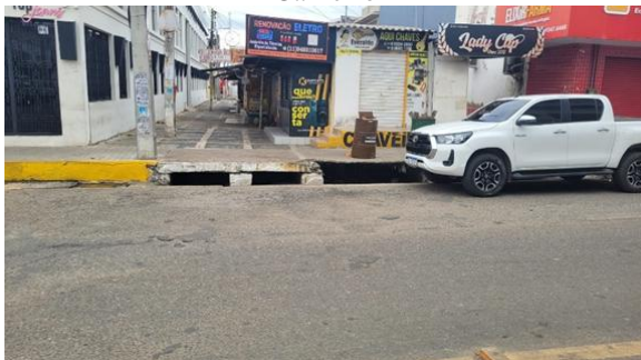
Figura 11: Boca de lobo na Rua Coronel Juvêncio Carneiro
