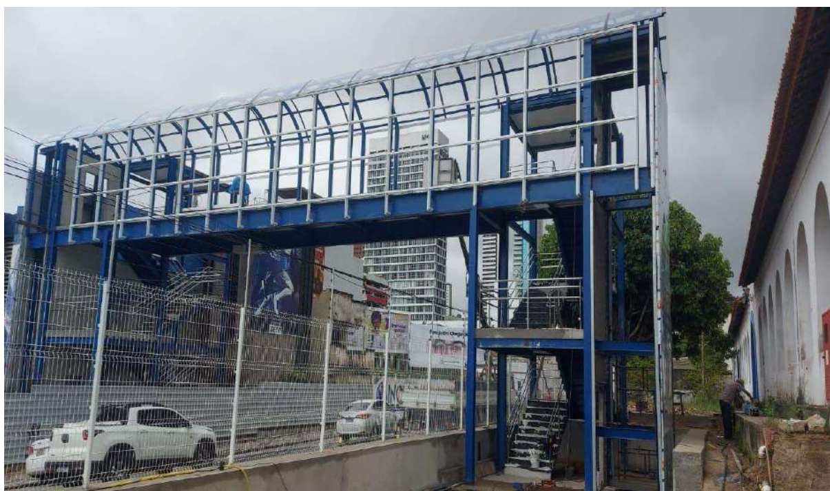
Figura 1 - Estrutura metálica da passarela que liga o SENAI Stenio Lopes ao Clube do Trabalhador Aprígio Veloso da Silveira
